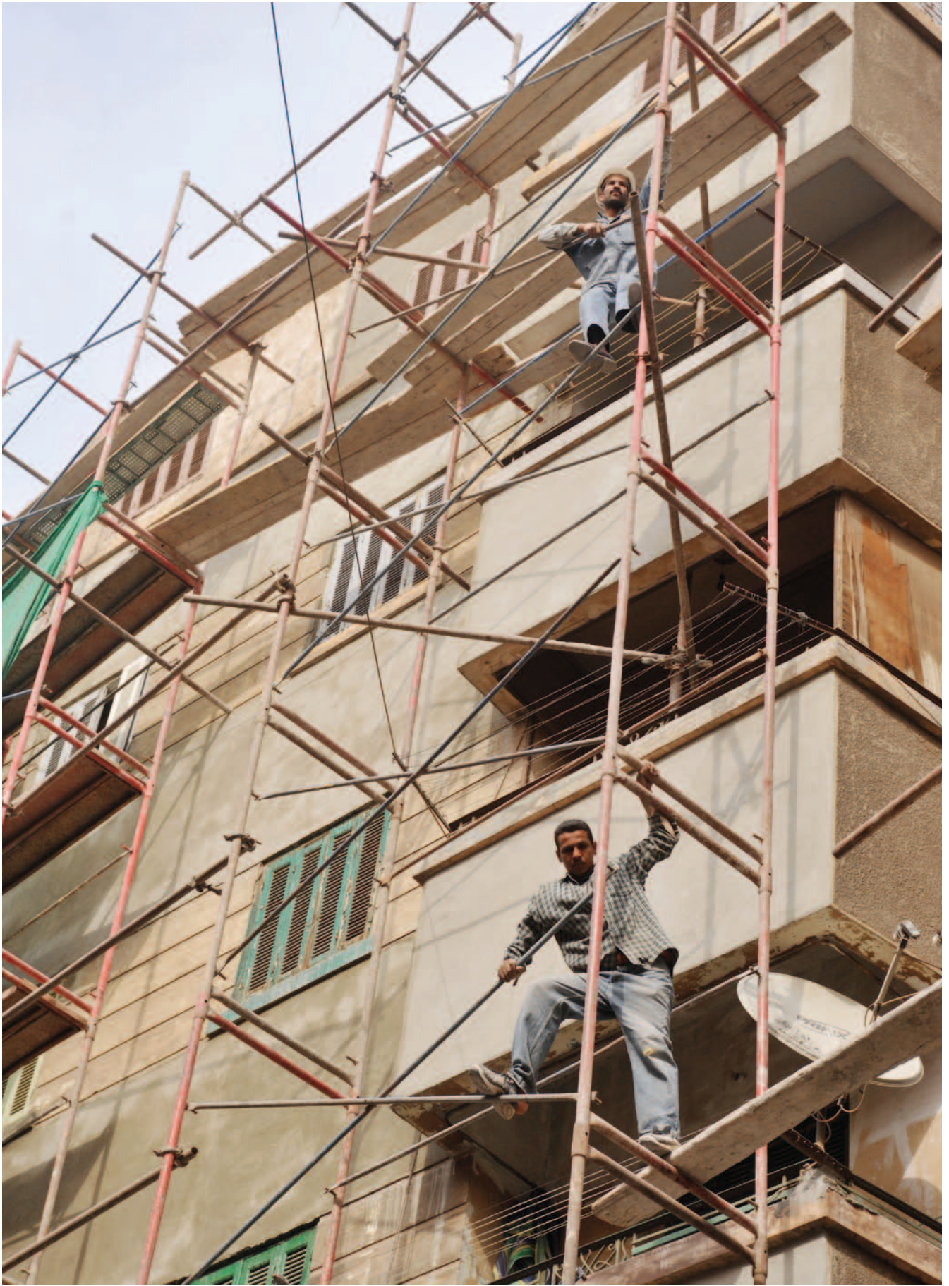
Trabajadores de la construcción, El Cairo, Egipto.
