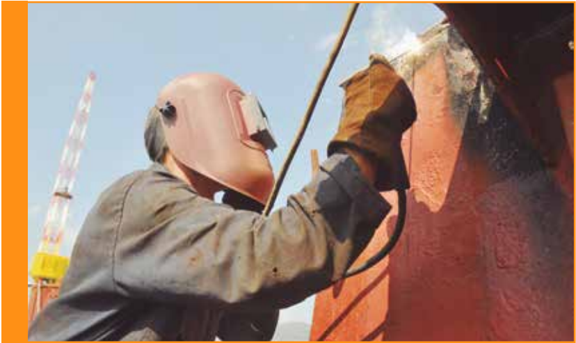
Trabajos de reparación con soldadura © OIT
