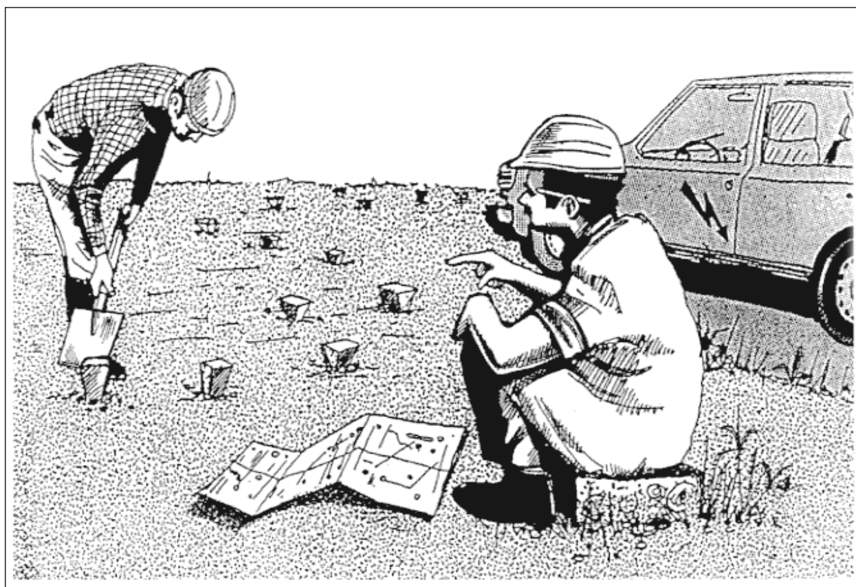
Figura 12. Localização e marcação da posição de cabos eléctricos enterrados a partir de uma planta.
