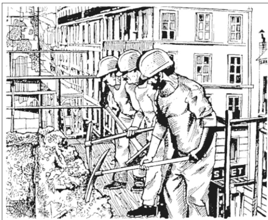
Figura 30. Uma plataforma de andaime a partir da qual é possível executar trabalhos de demolição em segurança.
