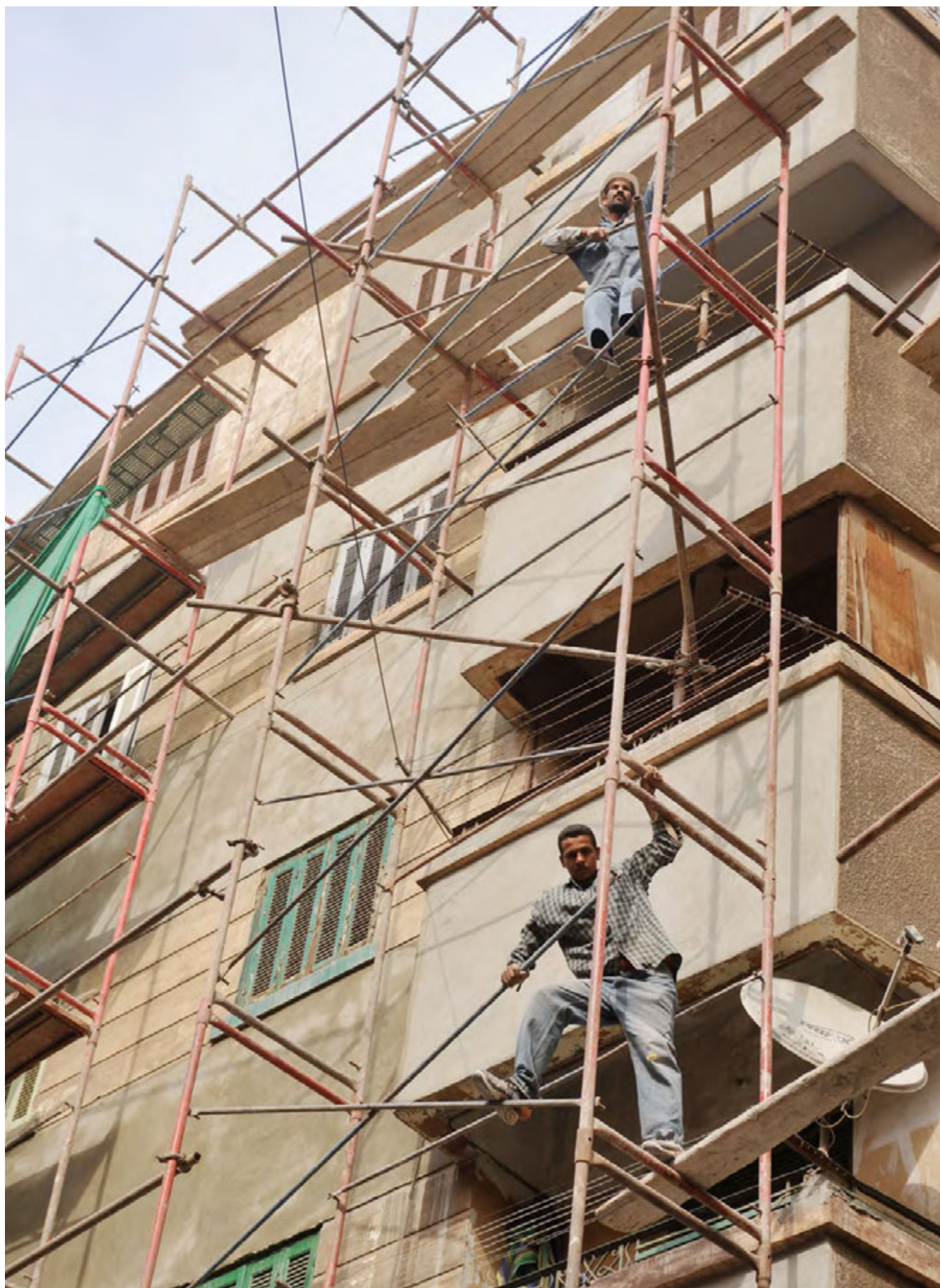
Trabalhadores da construção, Cairo, Egito.
