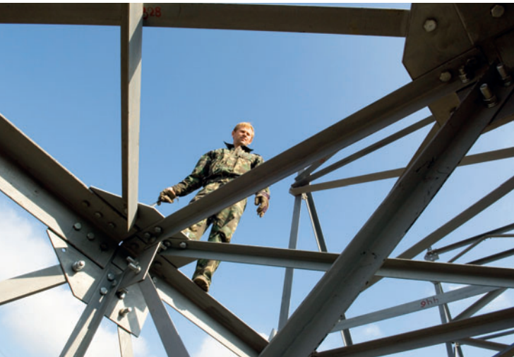
Arbeiter beim Bau eines Strommasts
