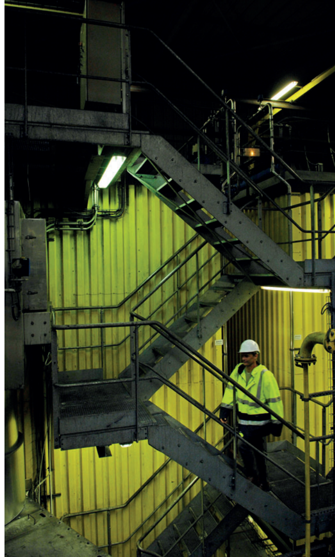
Wachstumssektor Abfallbehandlung und -entsorgung – hier eine Anlage in Frankreich © ILO
