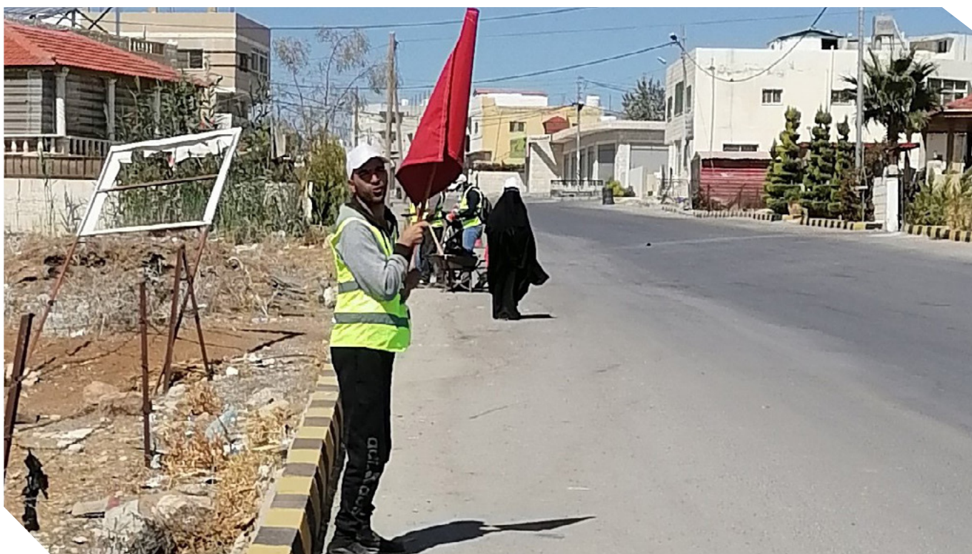
Jordanie, Commune de Mouab. Travailleur alertant les usagers de la route des travaux à venir. Programme des investissements à haute intensité de main-d'œuvre de l'OIT.
