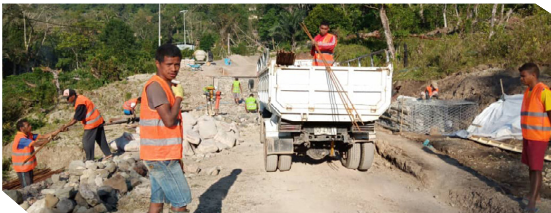
Timor Leste, Commune de Baucau. Travailleurs déchargeant des matériaux pour l'intersection Defawasi 1 – Section 04 de la Route Uacala. OIT ERA Agroforestry Project.
