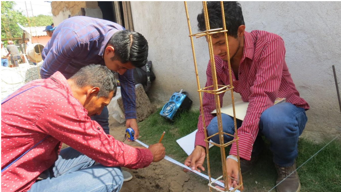
Verificación del trazo
