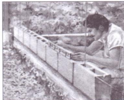
Figura 10-7. Se colocan 4 ó 5 bloques y se revisa el plomo, el nivel y la rectitud de la hilada.
