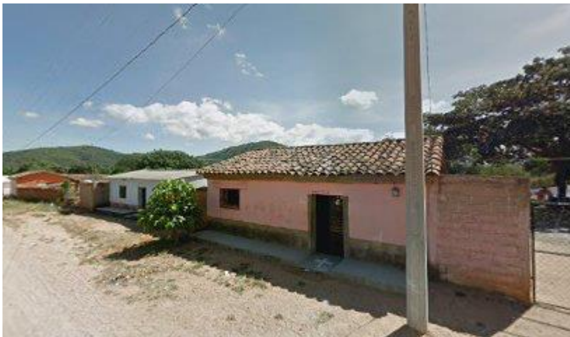
Aspecto de la localidad: Pomposo Castellanos
