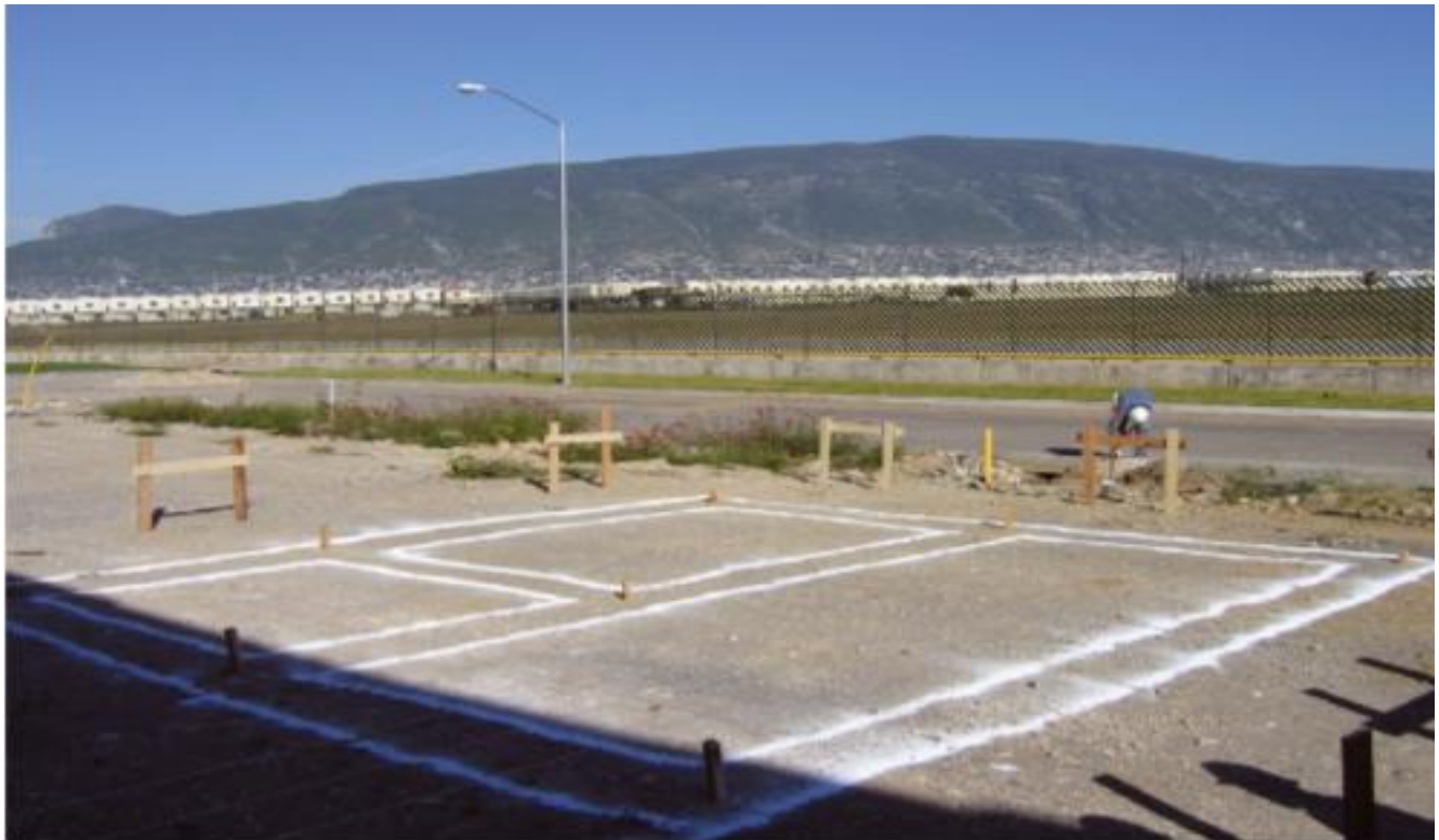
4.1.6 Verificación de excavaciones.
