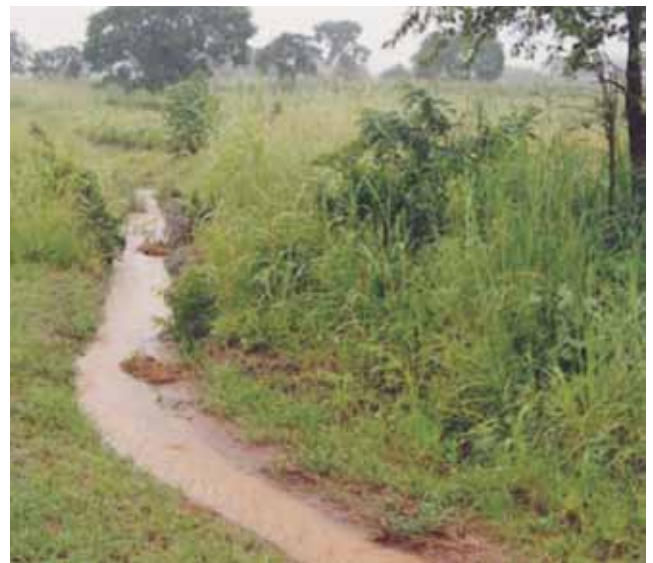
A functioning mitre drain
