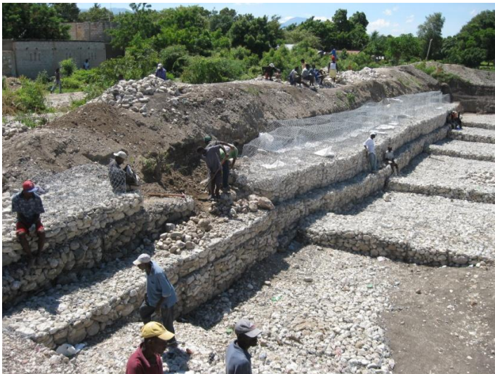
Les ouvriers de l'entreprise, payés à 600 HTG/m 3 façonnent, posent et remplissent les gabions de roches de rivières. Une structure de contre-seuils est créée pour casser la vitesse du courant laminaire de l'eau
