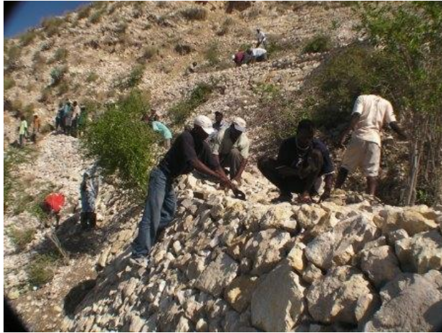
Elévation d'une digue en maçonnerie de pierres sèches à l'intérieur d'une ravine de manière à freiner les eaux
