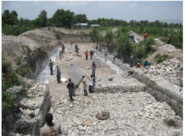
Travaux de renforcement de la culée du pont par une chute renforcée d'un contre-seuil avec couverture du radier par un tapis de gabions auquel s'ajoute le renforcement du lit de la ravine par des berges gabionnées sur 2m00 d'épaisseurs et 3m00 de haut..
