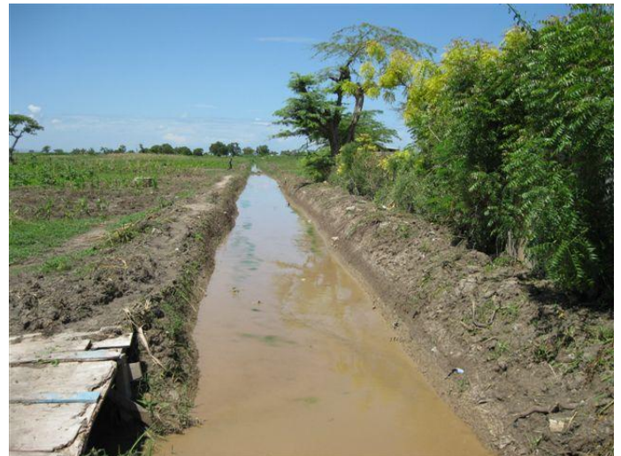
Vue des travaux du drain en terre terminé
