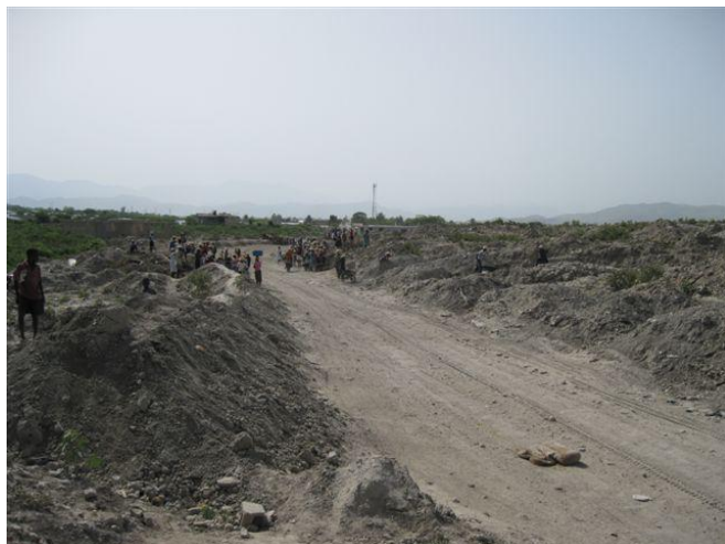
Situation avant intervention du projet. On remarque que les chauffeurs de camions déversaient les boues et débris de la ville des Gonaïves en bordure de la chaussée entraînant un rétrécissement de la chaussée de roulage des Gonaïves vers Hanse Rouge.
