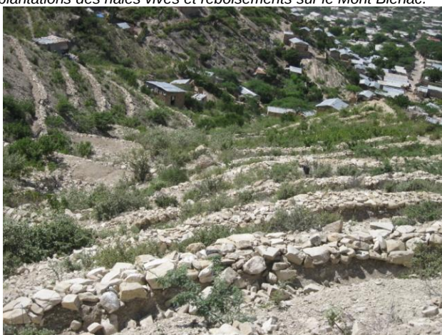
Résultat de la couverture végétale naturelle entre les fossés antiérosifs en raison du maintien des eaux sur les versants érodés
