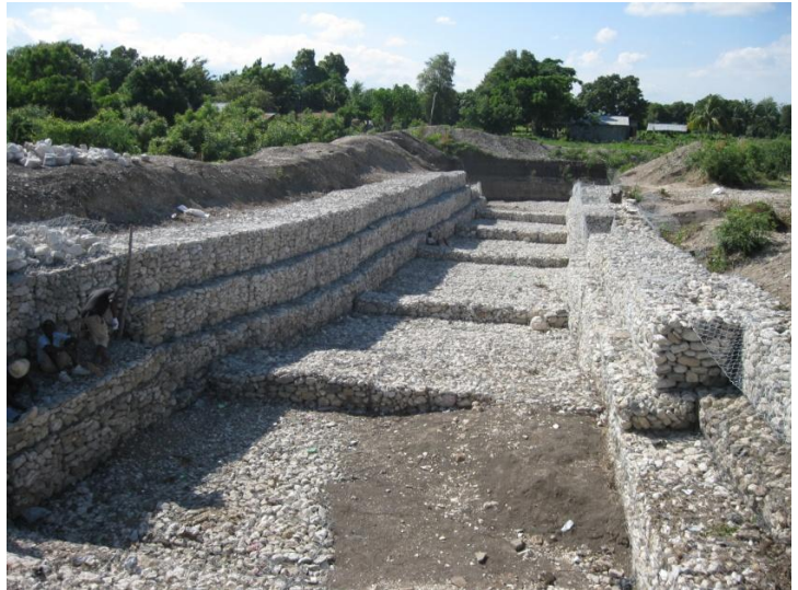
Vue d'ensemble de l'aval de l'ouvrage canalisant les eaux de crues de la ravine Durée vers le canal Bienac
