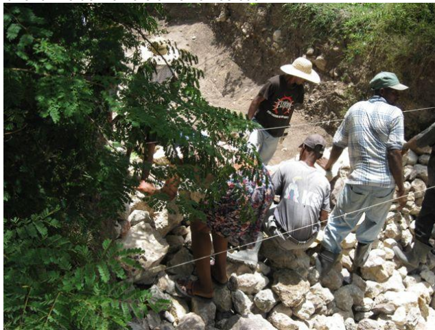
Opération de pose des roches dans une ravine de Maboue à l'intérieur du sous bassin de Bassin Magnan
