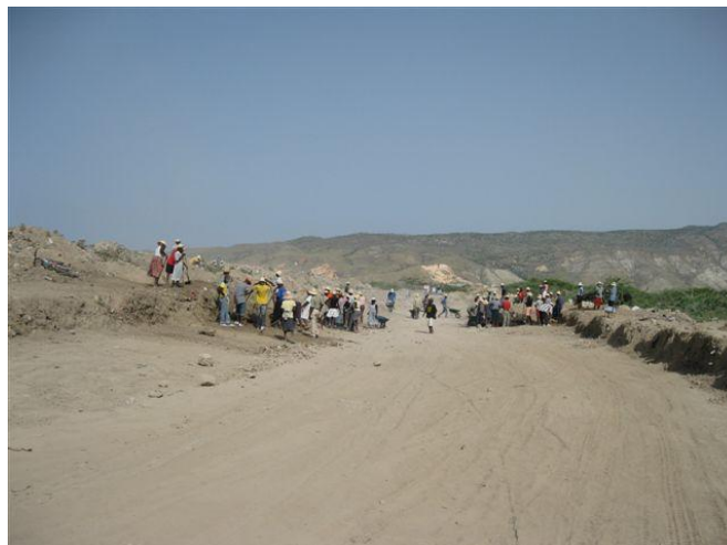
Situation après intervention. Elle sera consolidée par la seconde période des 25 jours qui entreprendra l'excavation des drains latéraux pour évacuer les eaux de surface de la piste et les évacuer vers des ouvrages d'art en place qui doivent être curés.
