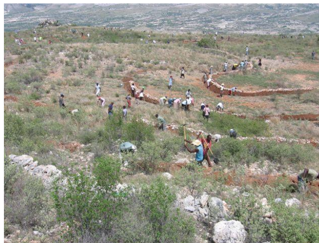
Vue d'un chantier de conservation des eaux et des sols sur le sommet du mont Bienac
