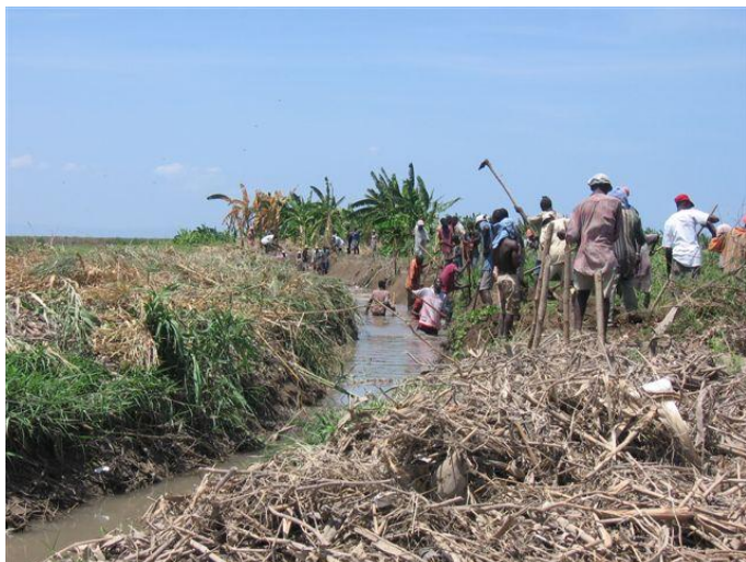
Vue du chantier de réhabilitation du lit naturel de la rivière La Quinte. Les travaux sont surtout à charge des travailleurs-homme vu la difficulté des tâches.
