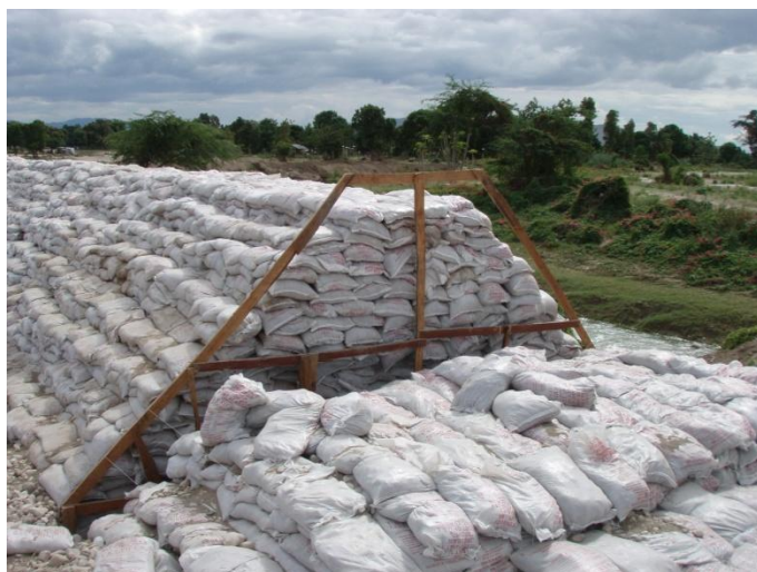
Vue d'ensemble du travail de colmatage de la brèche à Pont Tamarin dans une des brèches de la Rivière La Quinte suite au cyclone Hanna
