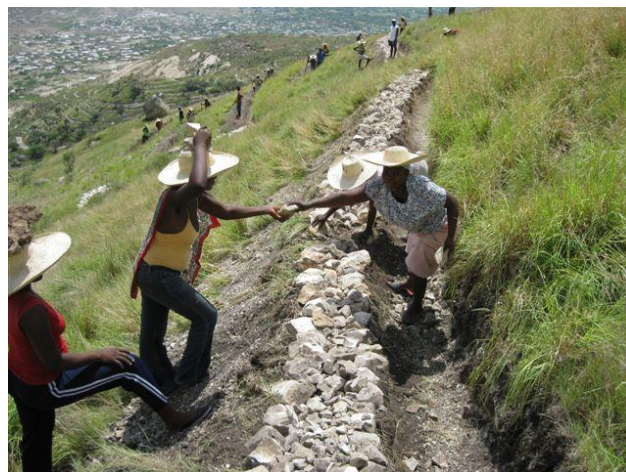
Vue d'ensemble d'un versant traité par fossés isohypses renforcés de cordons pierreux. Cette prise de vue a été réalisée deux années après exécution des travaux. Un constat de reprise de la végétation est nette.
