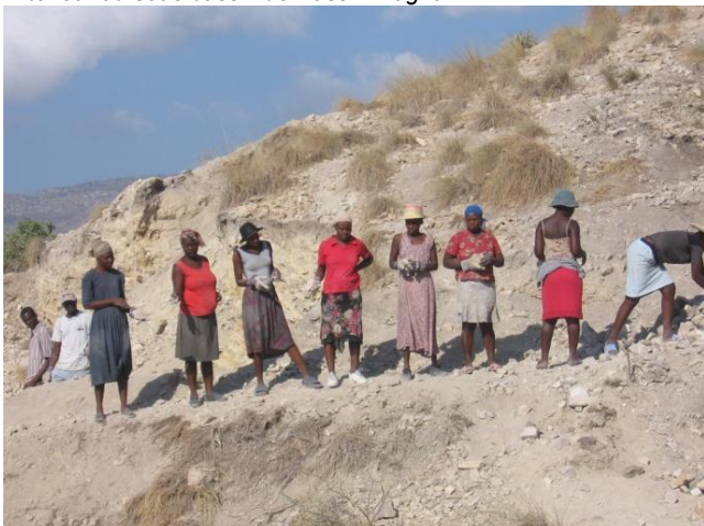
Opération de transport des pierres vers les sites de construction des seuils de pierres sèches
