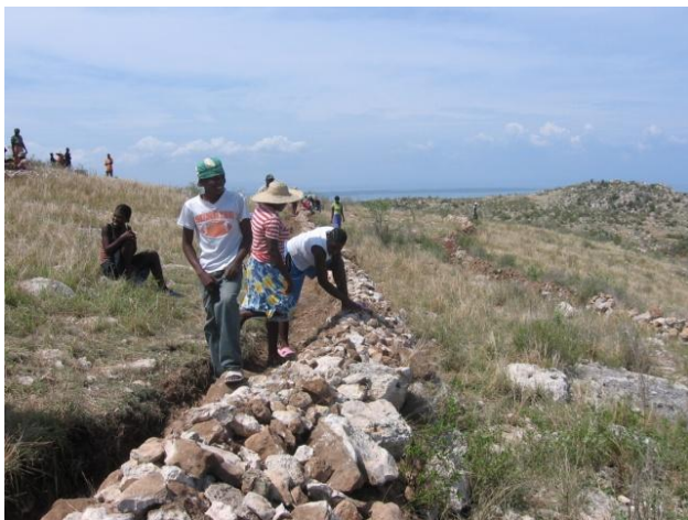
Après l'excavation des fossés isohypses renforcement des terres foisonnées par une couverture de pierres pour éviter tout affouillement vers l'aval des structures construites
