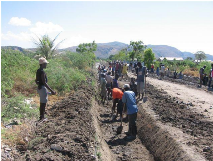
Excavation du drain de ceinture du périmètre irrigué de Gramont
