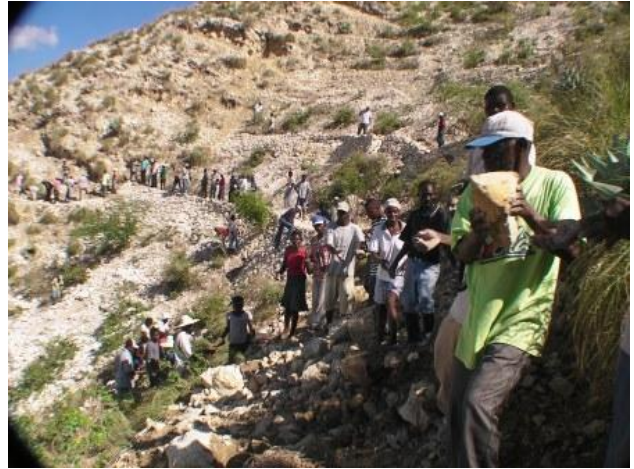
Organisation des travailleurs pour l'extraction et le transport des roches vers les seuils de rétention en eau
