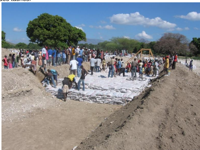
Colmatage des fondations de la digue temporaire par des sacs de sable sur la brèche de Mapou en bordure de la Rivière La Quinte
