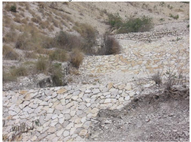
Vue d'ensemble d'une ravine traitée par des seuils de rétention en eau maçonnées en pierres sèches
