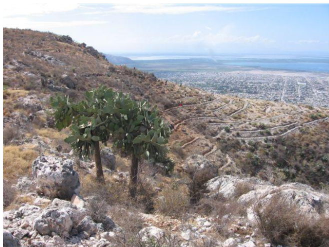
Vue d'ensemble du versant de Bienac Sud traité par des réseaux de fossés antiérosifs renforcés de cordons pierreux
