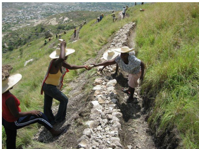
Vue d'ensemble d'un chantier de renforcement des fossés par des cordons pierreux recouvrant les terres foisonnées de l'excavation des fossés antiérosifs (chantier de Bretagne).
