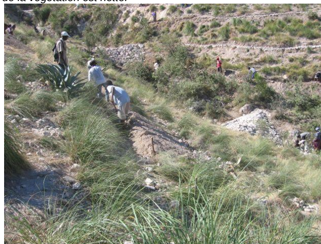
Excavation des fossés antiérosifs suivant un rendement journalier de 10m00 x 0m50 x 0m50. Deux seuils sont visibles dans la ravine (chantier de Gattereau).
