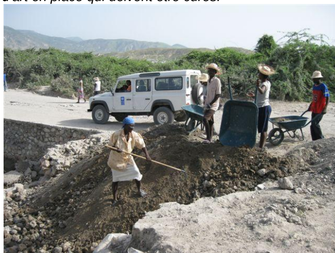
Recouvrement des immondices du site de manière à recréer un talus aux normes techniques en tête de pont busé réceptionnant les eaux de la ravine Sèche
