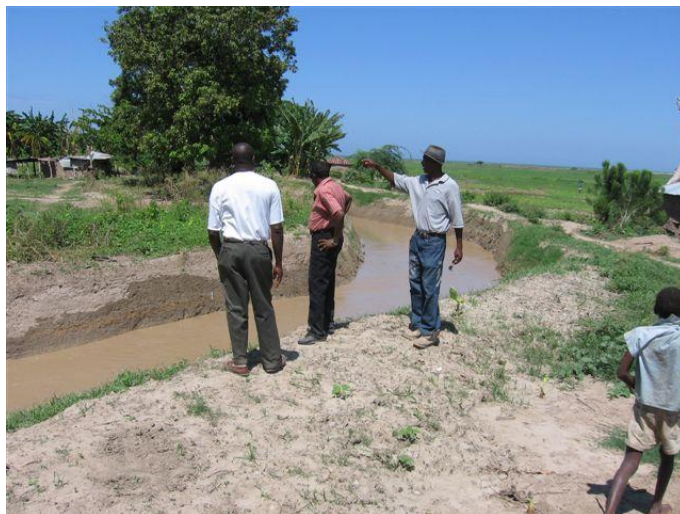
Vue du chantier achevé de la réhabilitation du lit naturel de la Rivière la Quinte demandé par les agriculteurs de Granmont
