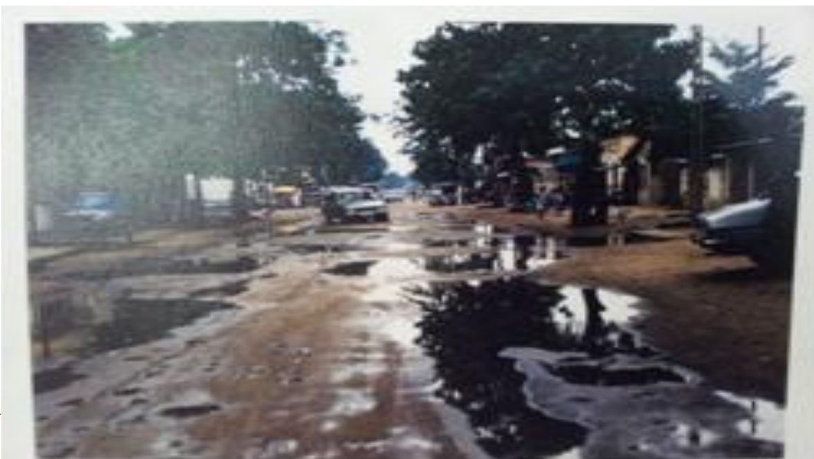
Rue des Cheminots à Cotonou - situation avant le pavage.
