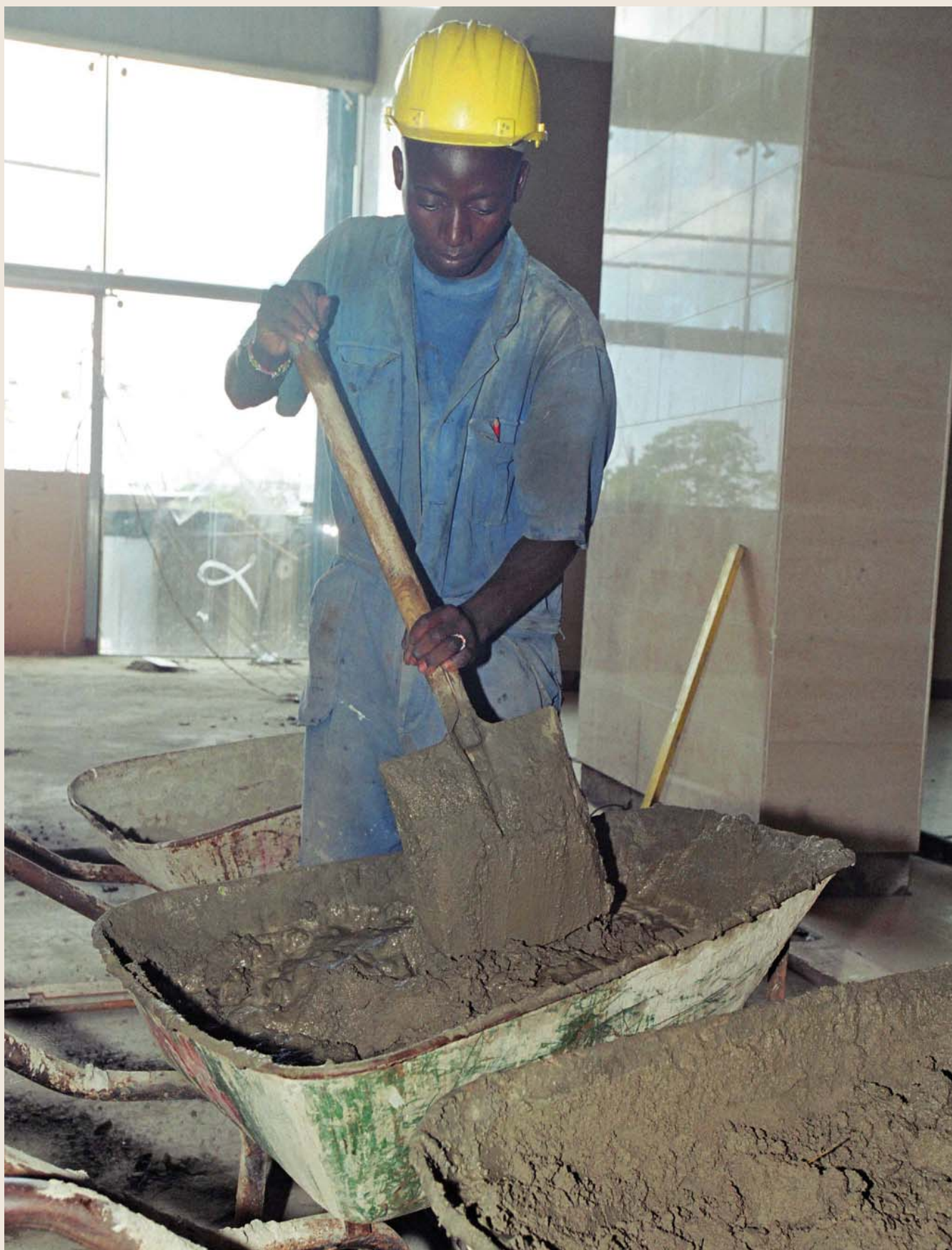
Un briqueteur sur un chantier à Dar es Salaam, République-Unie de Tanzanie. L'industrie du bâtiment est un autre secteur dans lequel l'auto-emploi et le travail indépendant sont courants.
