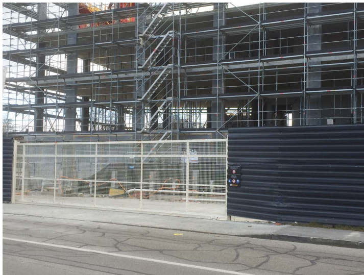
Ilustración 2. Obras de construcción cercadas
