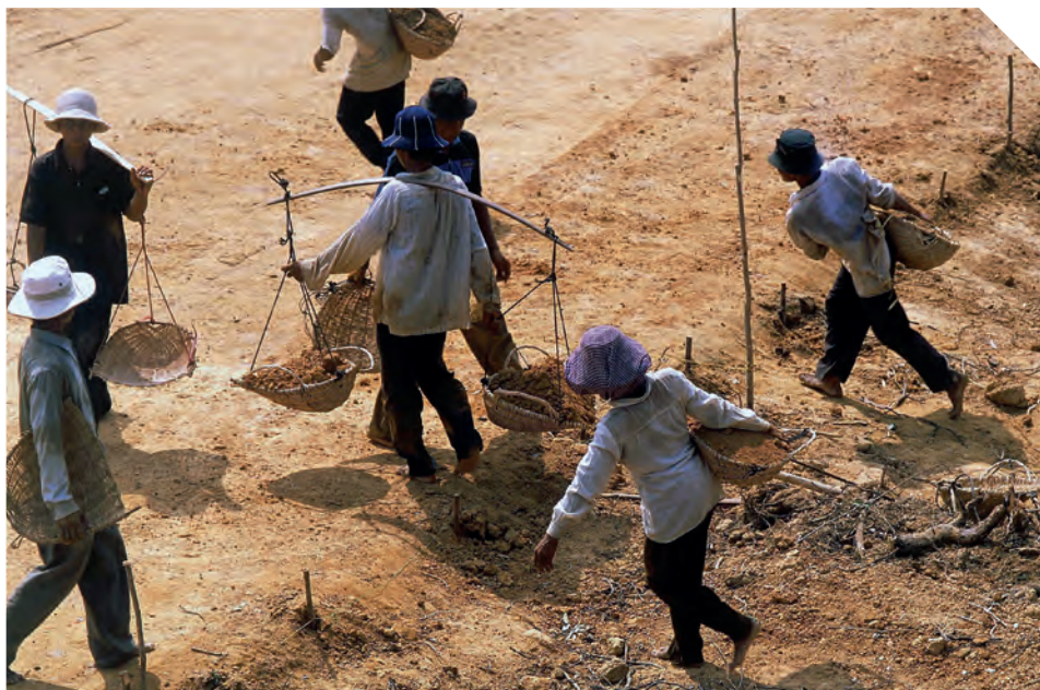
La restauration du site archéologique d'Angkor Vat à proximité de Siem Reap (Cambodge) et la construction du réseau routier qui le dessert ont été réalisées dans les années quatre-vingt-dix grâce à un programme à haute intensité de main d'œuvre du BIT.
