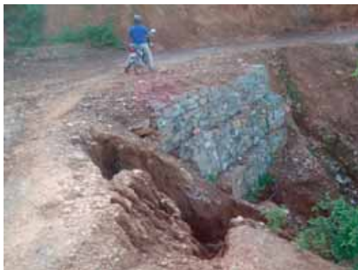
सडकको किनारामा चिरा परेको
