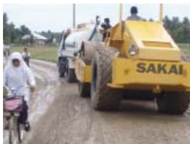
Pemadatan sekaligus pemberian air untuk mendapatkan kadar air optimum pada pekerjaan lapis pondasi bawah
