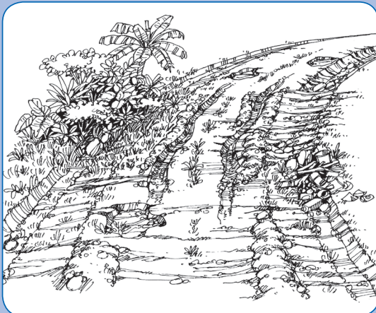
Kondisi jalan setelah 3-5 tahun tanpa pemeliharaan
