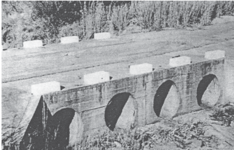
Gambar 17: Gabungan Drift dengan Beberapa Gorong-gorong (Vented Causeway)
