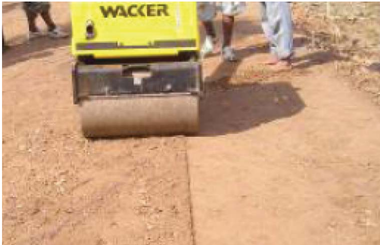
Gambar 14: Pastikan ada cukup tumpang-tindih ketika Anda melakukan Pemadatan
