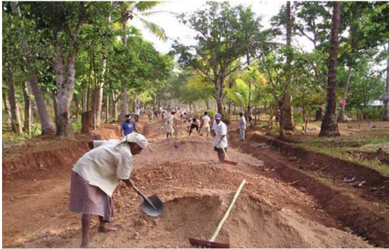
Gambar 10: Penentuan penyebaran kerikil
