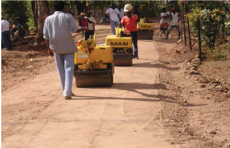
Gambar 12: Pemadatan dengan penggiling getar pejalan kaki
