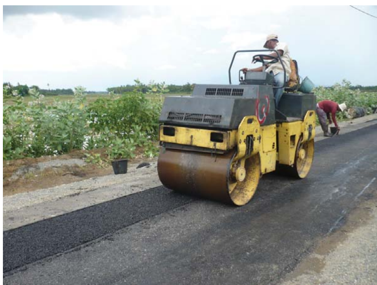
Gambar 41: Pemadatan campuran dingin
