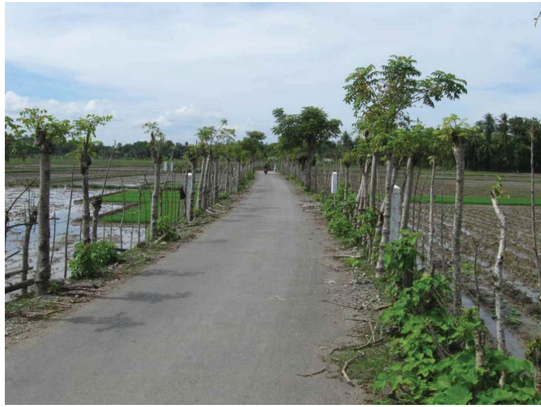
Gambar 42: Potongan jalan selesai dibangun
