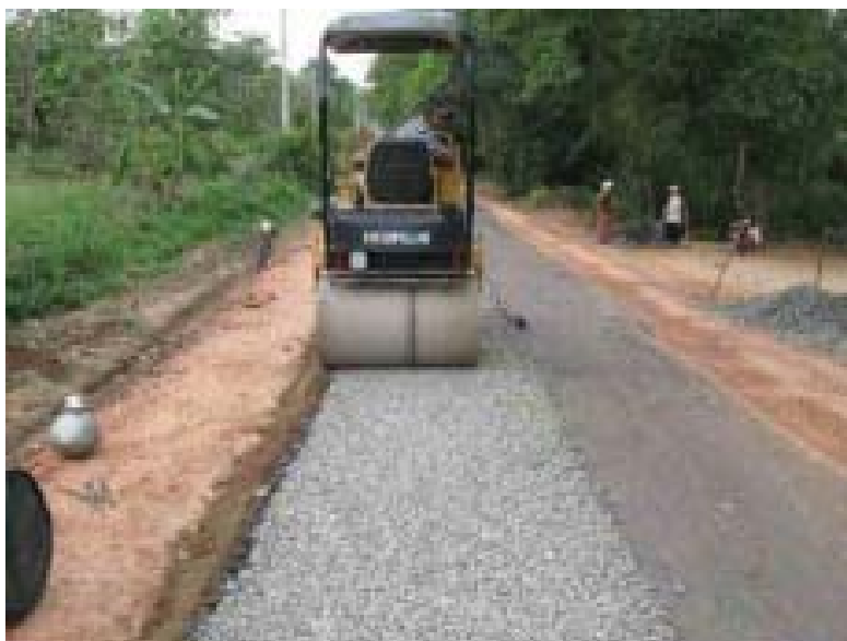
Gambar 44: Pemadatan agregat
