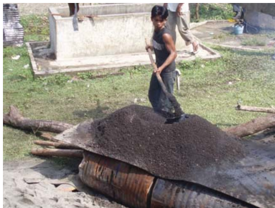
Gambar 46: Pencampuran dan pemanasan Latasir
