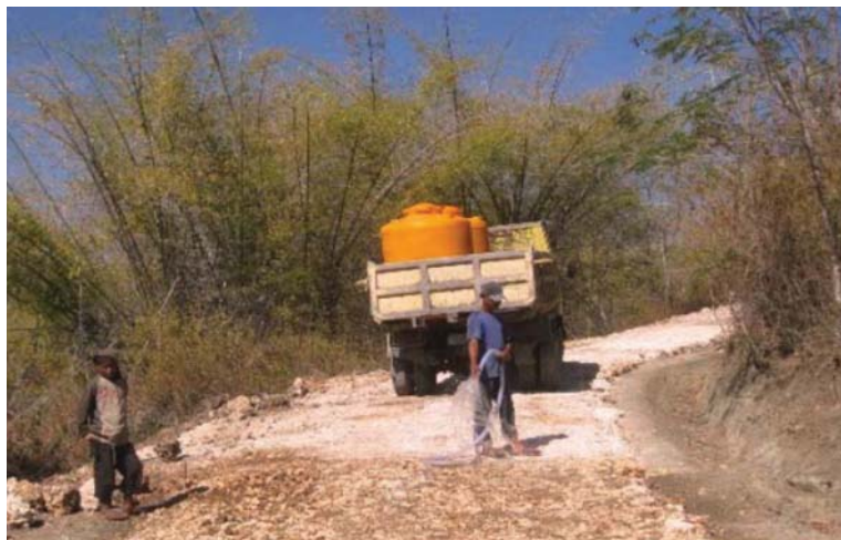
Gambar 11: Penyiraman sebelum Pemadatan
