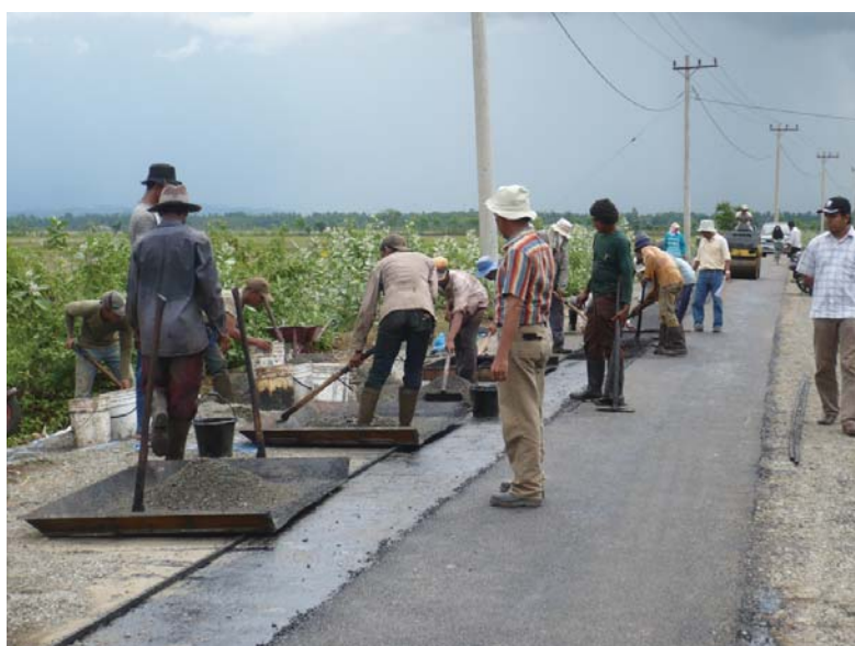
Gambar 40: Penghamparan dan penyaringan campuran dingin
