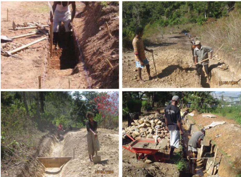
Gambar 15: Pekerjaan saluran drainase samping: penggalian, pemasangan batu dan pemeriksaan penampang
