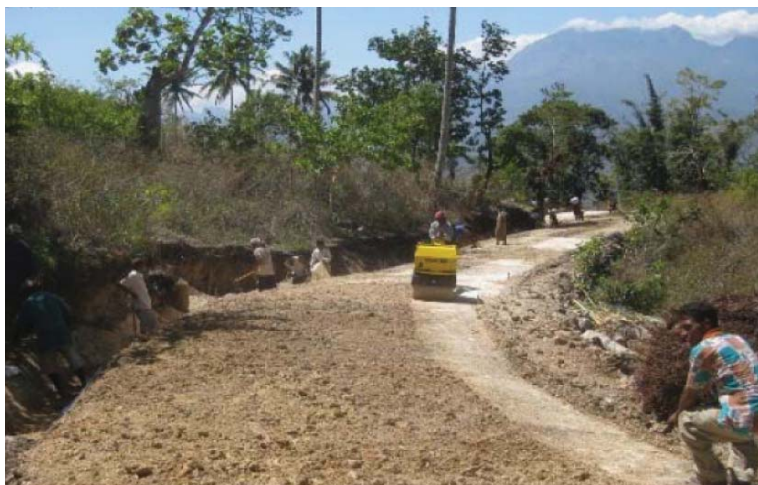
Gambar 8: Pemadatan dan Pembentukan Kemiringan Jalan
