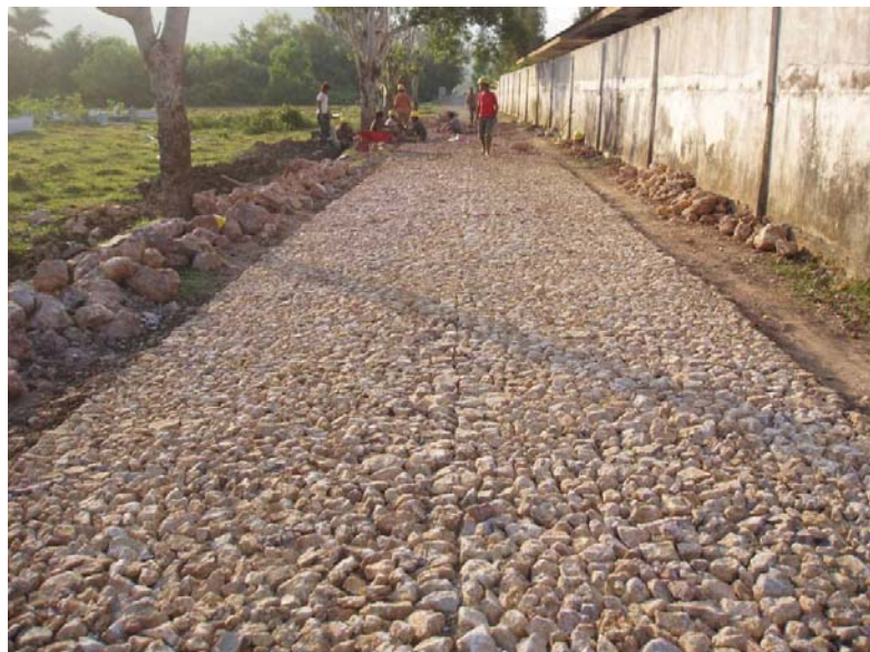
Gambar 43: Jalan telford sedang dibangun
