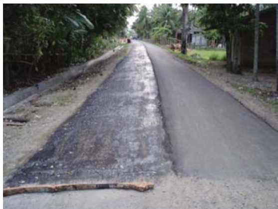
Gambar 47: Penghamparan perkerasan
