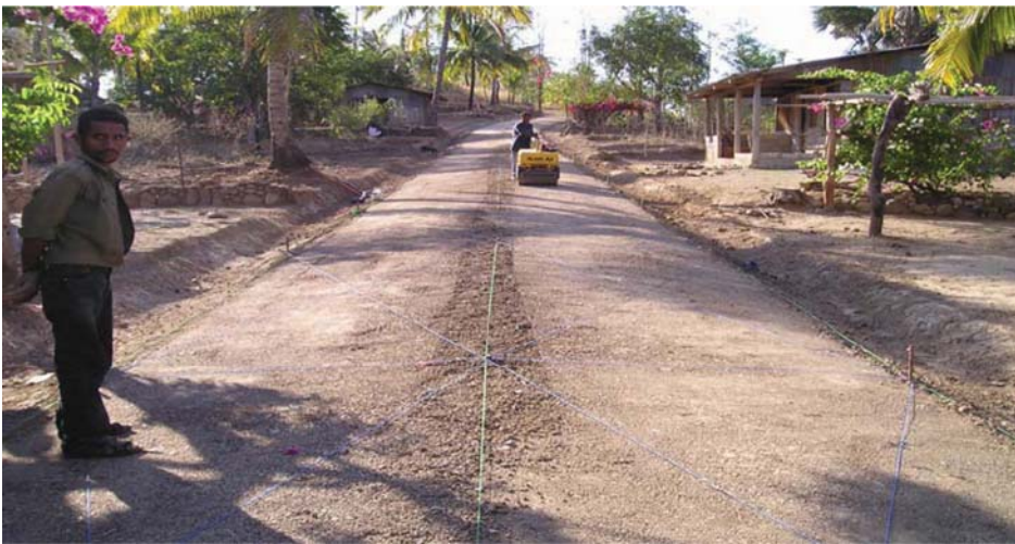
Gambar 9: Mengecek lengkungan menggunakan pasak dan benang
