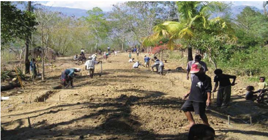
Gambar 6 : Membangun lengkungan dengan tanah dari saluran samping
