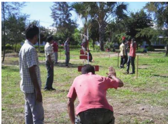
Gambar 4: Memeriksa lereng di sepanjang garis tengah
