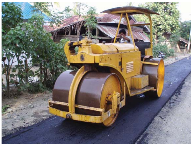
Gambar 49: Pemadatan lapisan Latasir
