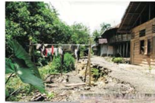
Jalan yang terkena imbas gempa bumi di Nias.
