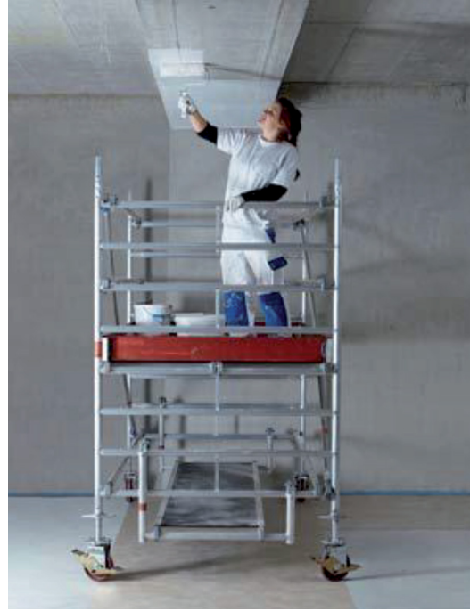
الصورة ١٦. سقالة متحركة قيد الاستعمال، مبنية حسب المعايير.
