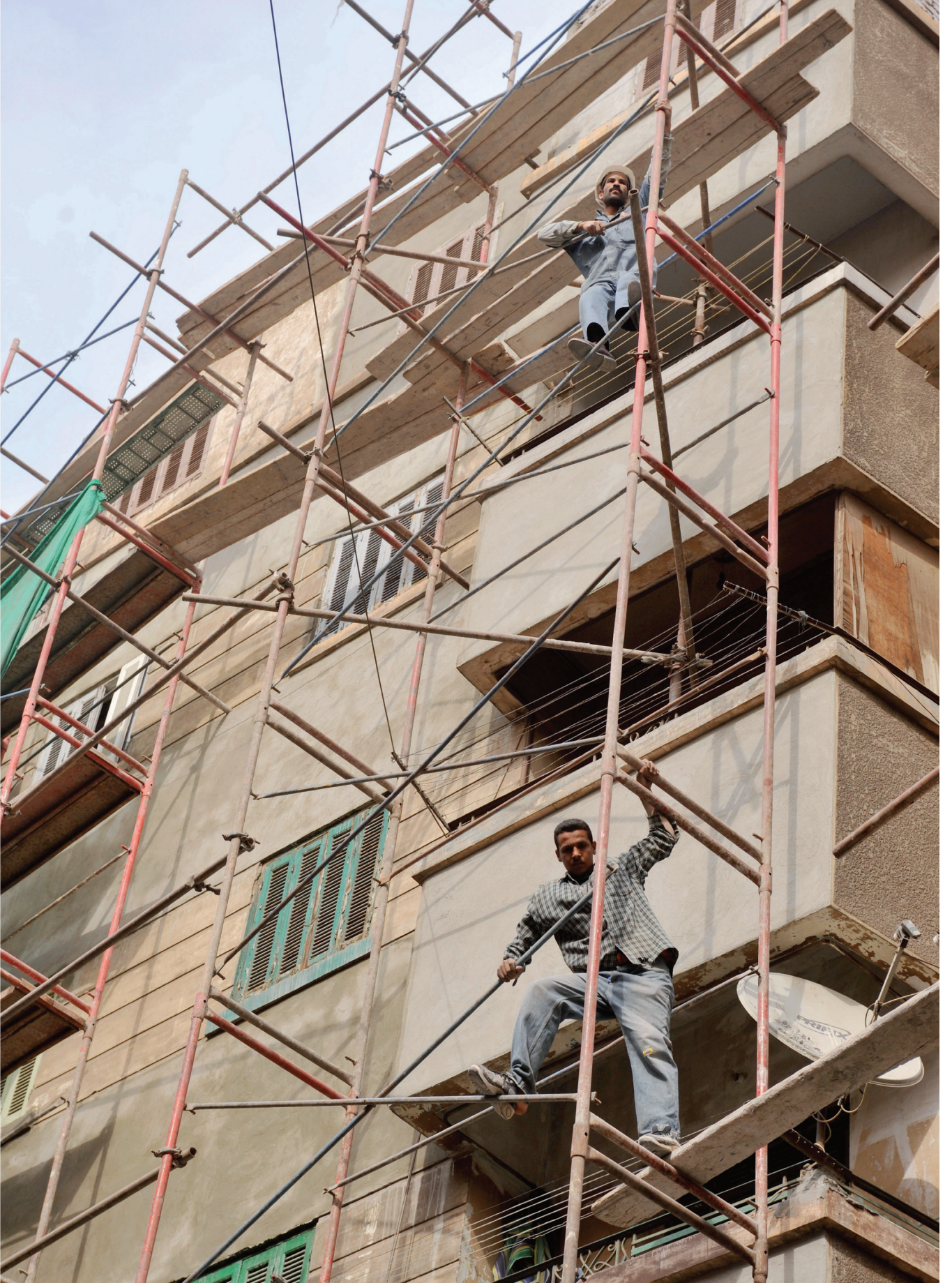
عمال في البناء، القاهرة، مصر.
