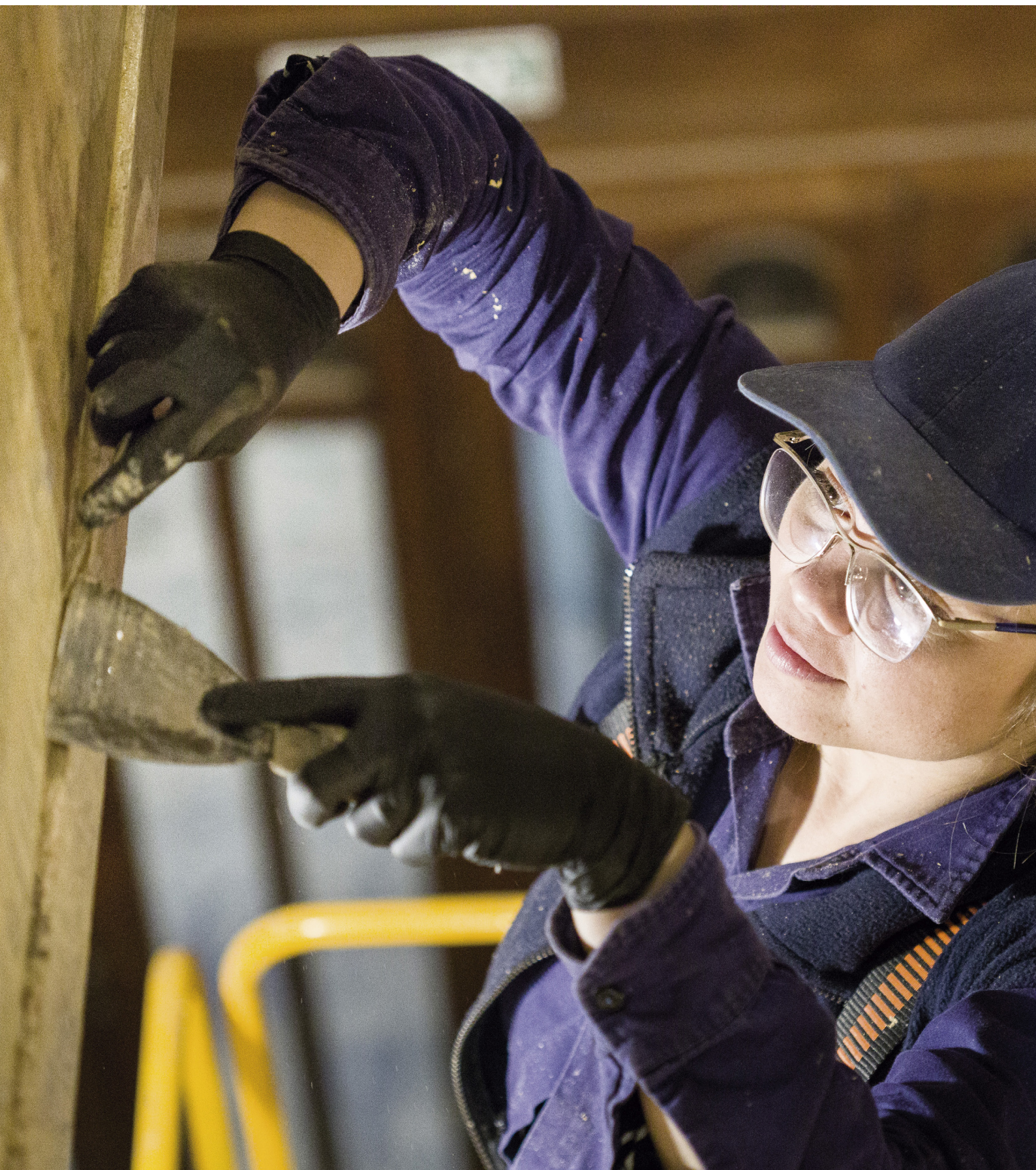
Restauradora decapando una pared
