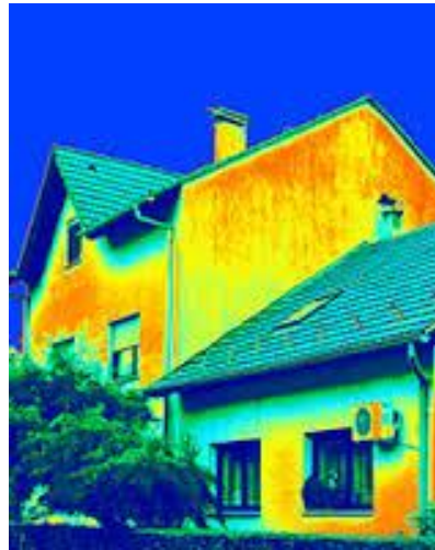
Eficiencia energética en edificios – la experiencia de Alemania
