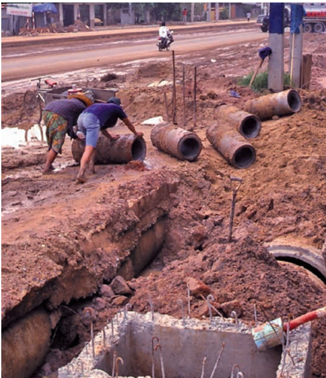
Construção de sistema de drenagem em Payao, Tailândia © Adrian Atkinson
