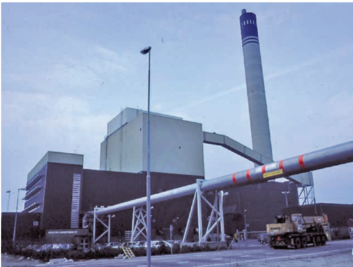
Usina de geração combinada de calor e energia (CHP) na Suécia © Adrian Atkinson
