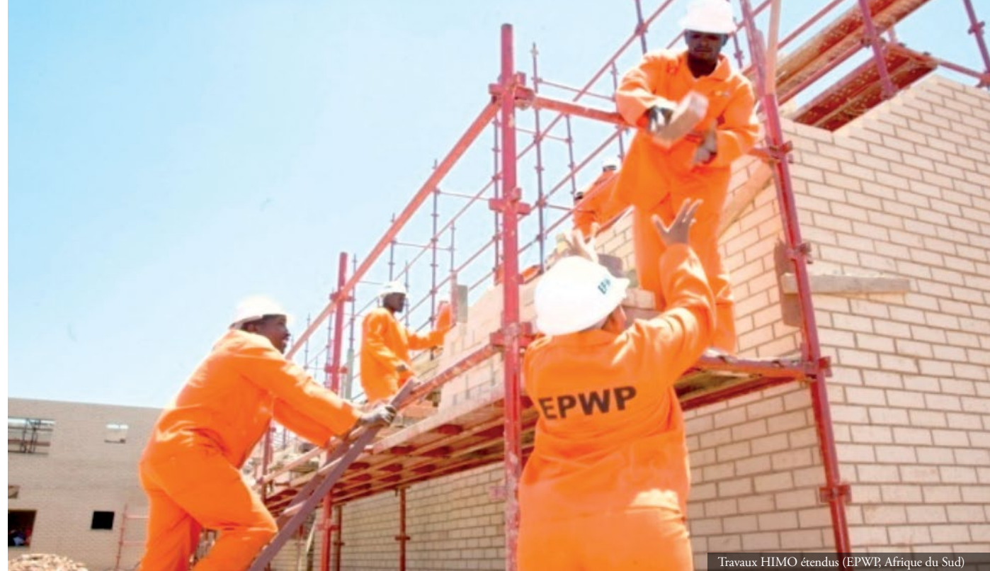
Travaux HIMO étendus (EPWP, Afrique du Sud)
