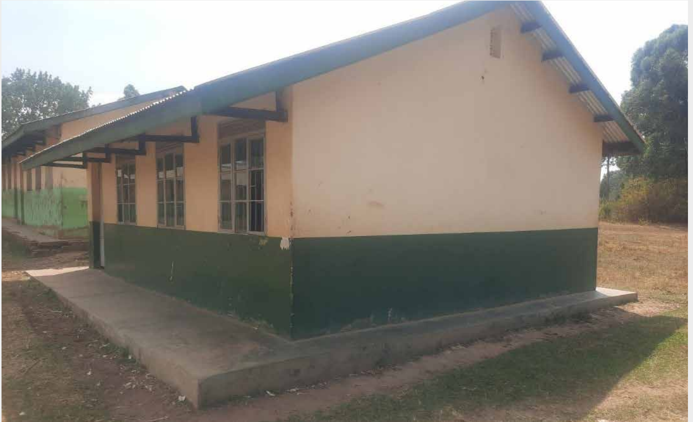
► Figure 2. Salle de classe de l'école primaire Kyabaseke, construite par le domaine de production de thé de Bugambe
