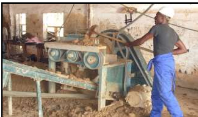
Production pilote des briques cuites
