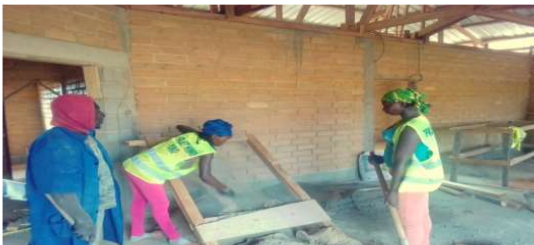
Tamisage du sable pour crépissage
