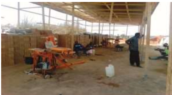
Atelier de formation à la production des briques de terre stabilisées
