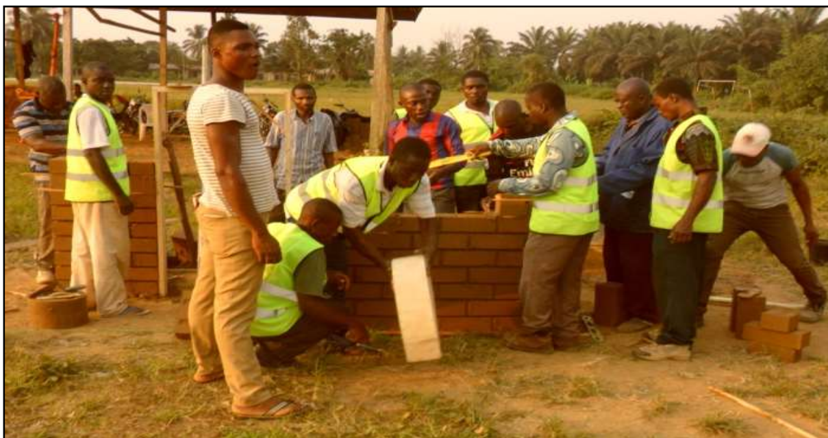
Formation des jeunes de la commune de Ndian à la production et mise en œuvre des BTC (Ekondo Titi)
