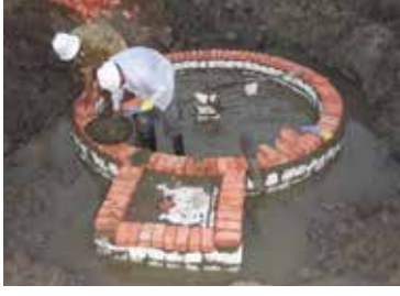
أعمال بناء وحدة الغاز الحيوي
