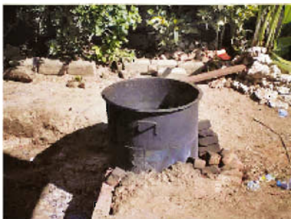
Figure 13 : Un matériel d'échaudage
