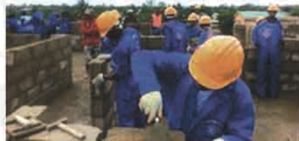
Jeunes en cours de formation en maçonnerie à Toamasina
