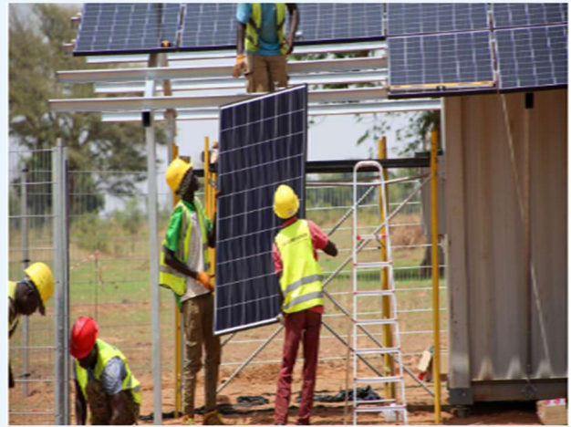
Secteur de la fabrication et de l'installation des panneaux solaires : Un gisement d'emploi potentiel pour les jeunes
