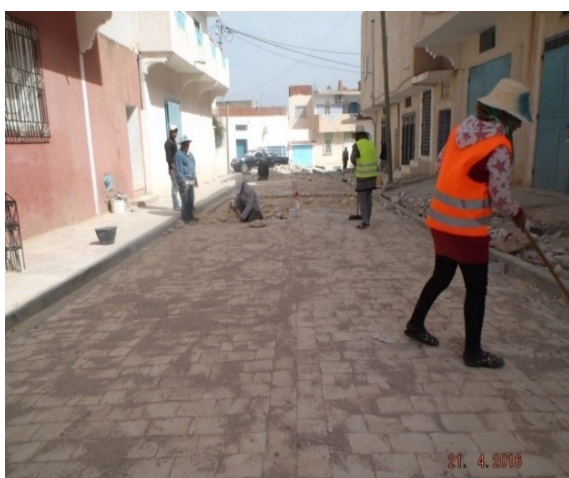
► Figure 14 : Travaux d'aménagement des voiries urbaines en pavée de pierre naturelle à joint sec
