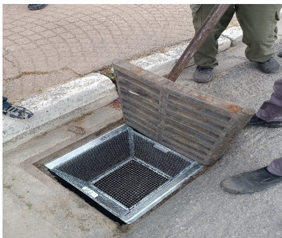
► Figure 15 : Installation de filtres dans les regards d'évacuation des eaux pluviales
