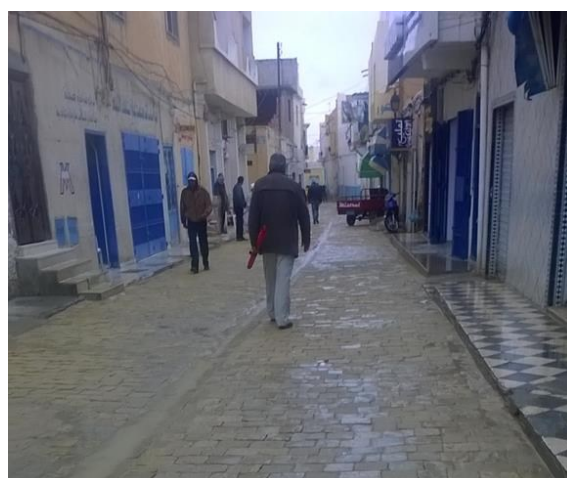
► Figure 14 : Travaux d'aménagement des voiries urbaines en pavée de pierre naturelle à joint sec
