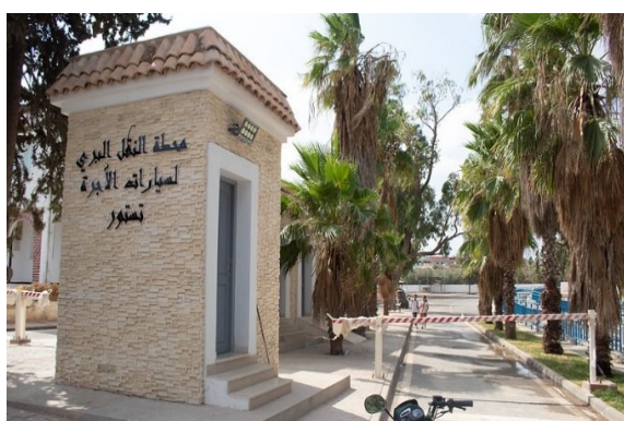
► Figure 16 : Station de transport terrestre à Testour
