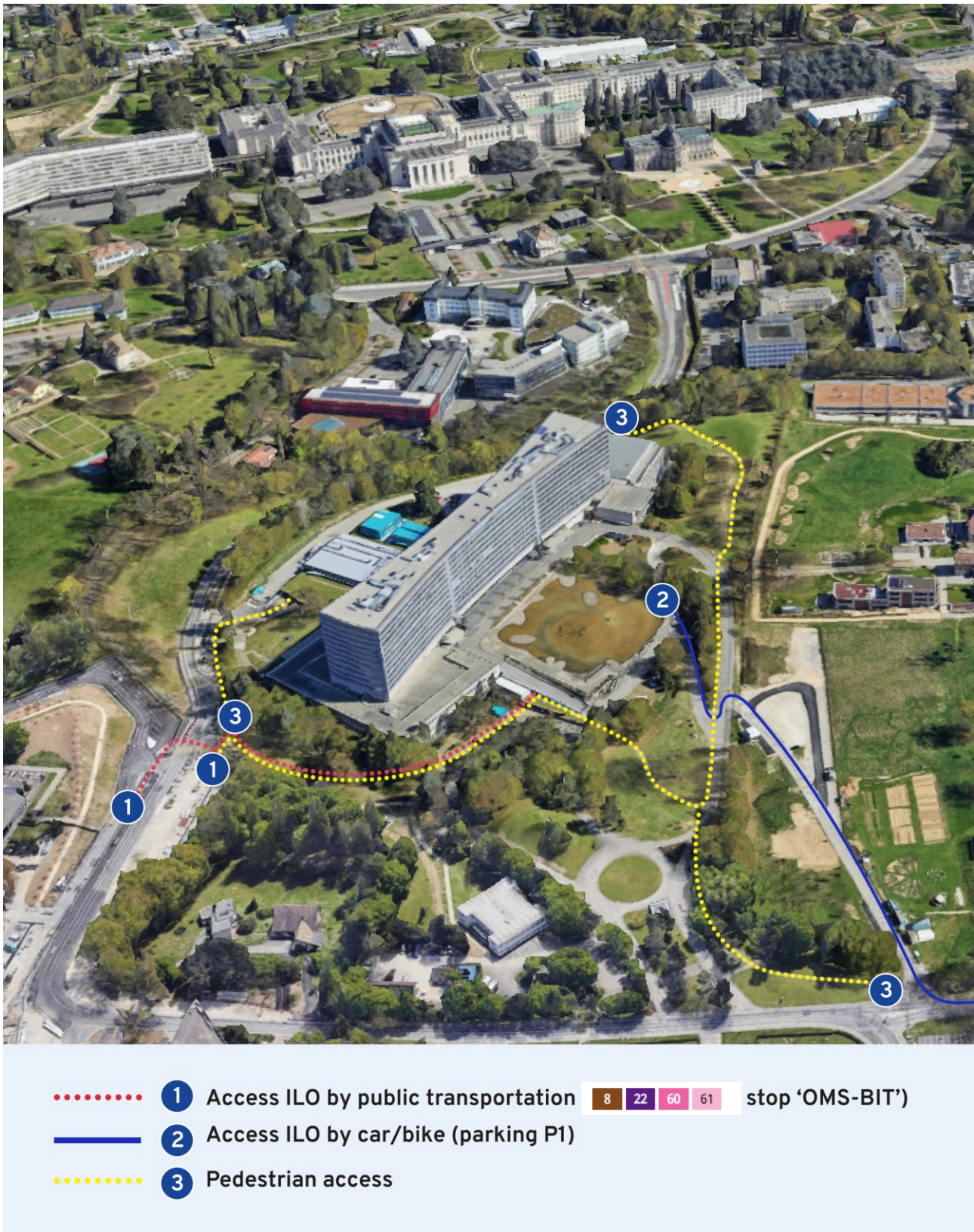
Figure 2 vue aérienne du BIT avec les différents accès au bâtiment par type de transport
