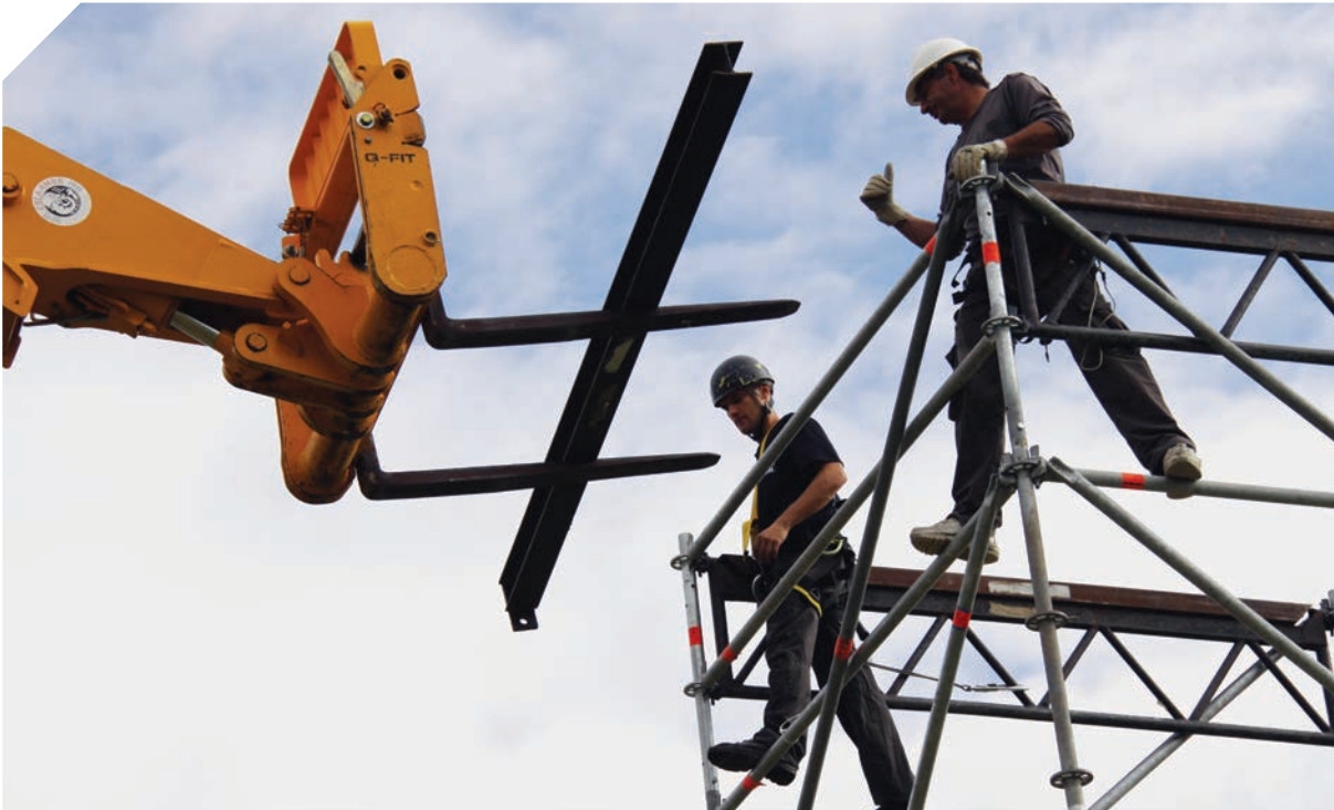
Remontagem técnica de andaime, França. © Legoupi S. / OIT.
