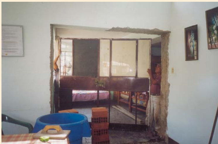
Construcción de las casas del sistema de “viviendas solidarias”.
