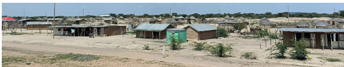
Site de mini-réseau dans le comté de Turkana. © OIT/Collins Oyuma
