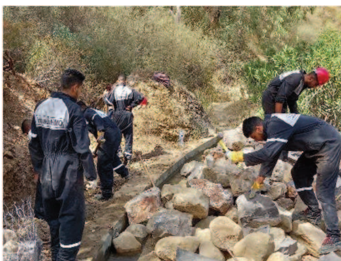
Figure 1: Travaux de conservation des eaux-commune de Galâa-Maâden-Forgsan
