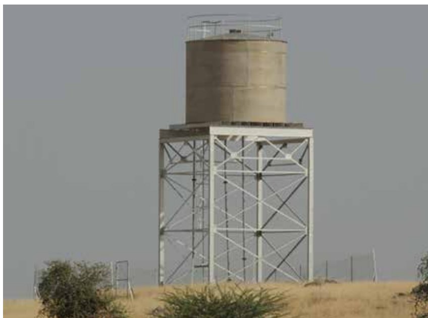
Figure 7: Château d'eau en INOX de 50m3 sur le site urbanisé pour les bénéficiaires (refugiés maliens /autochtones) du site urbanisé d'Ayorou afin de faciliter l'occupation des abris construits sur les parcelles sociales.
