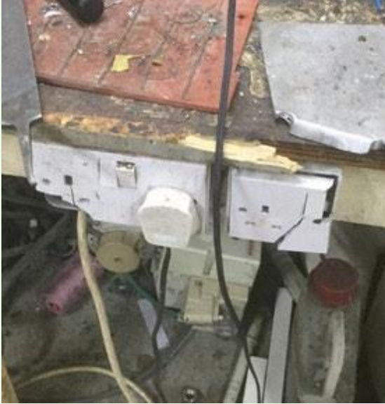
► Hình 50. Một ví dụ kém về cáp điện (với cách điện đơn và một đầu nối 'choc-box' không được bảo vệ đầy đủ khỏi những hư hỏng cơ học hoặc điều kiện thời tiết bất
