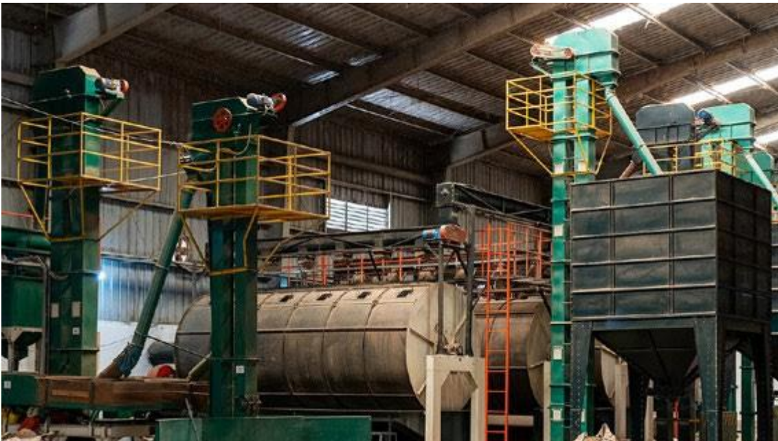
► Hình 36. Thanh lan can được lắp vào sàn công tác để ngăn NLĐ ngã cao.
