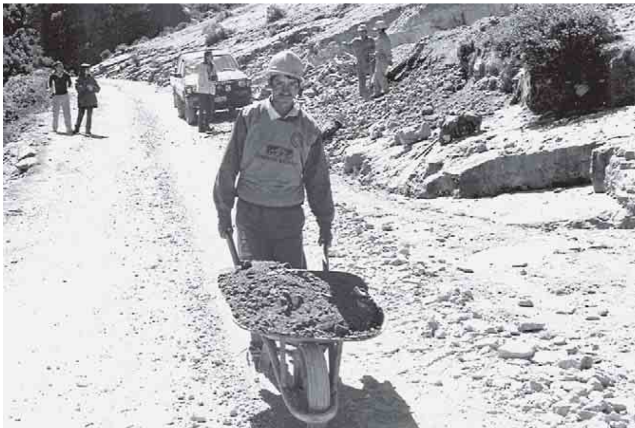
Microempresa de mantenimiento rutinario de caminos en plena operación
