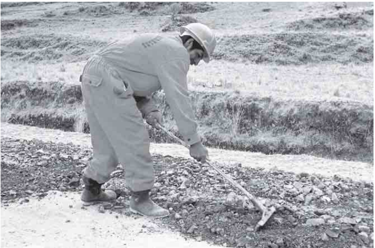
Limpiando la superficie de la rodadura
