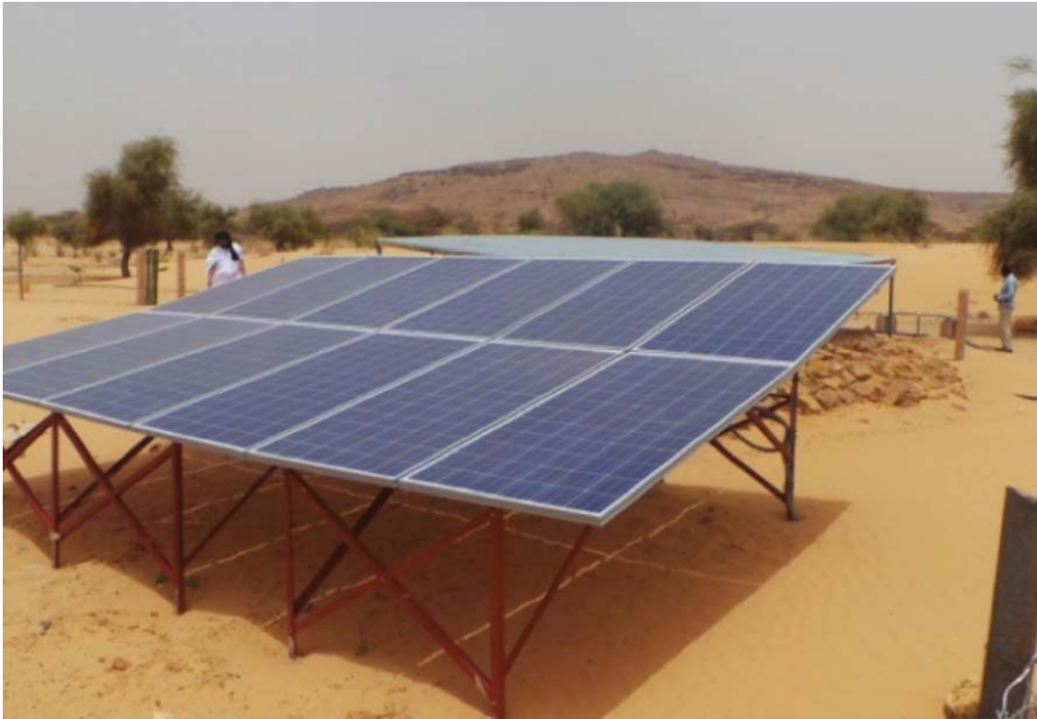
Installation de panneaux solaires en zone isolée, CDS, www.cds.mr
