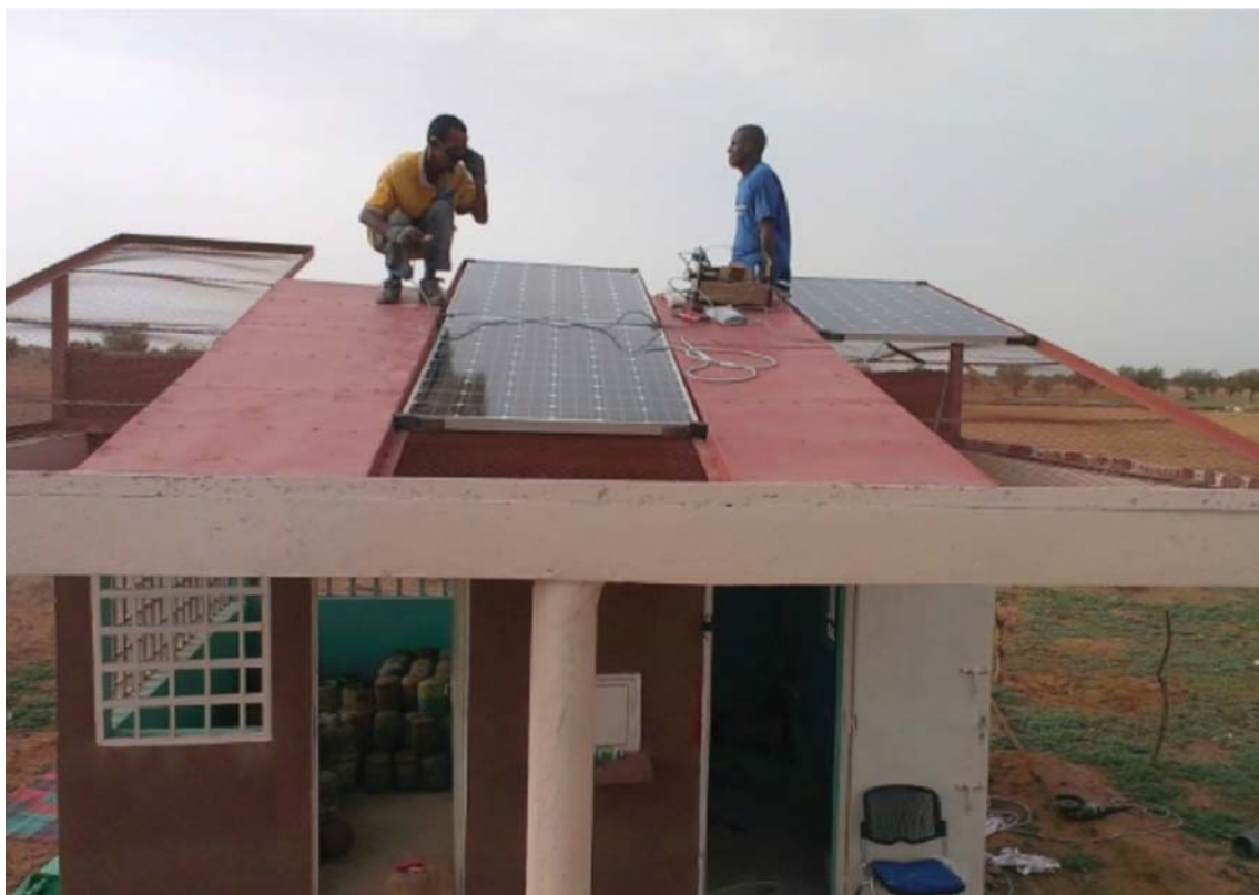
Installation d'une plateforme solaire multiservice dans une boutique rurale, source : CDS ( www.cds.mr )
