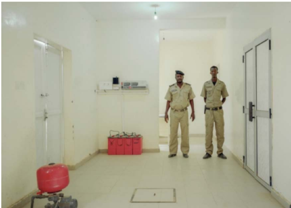
Installation de kits solaires dans un poste frontière enclavé, source CDS ( www.cds.mr )
