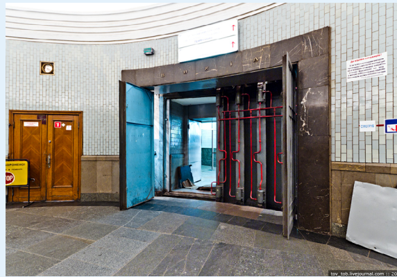
Фото 2.10 — Закриття гермозатвору (вестибюль станції «Вокзальна» КП «Київський метрополітен»)
