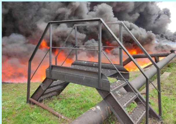
Фото 2.6 – Пожежа на трубопроводі
