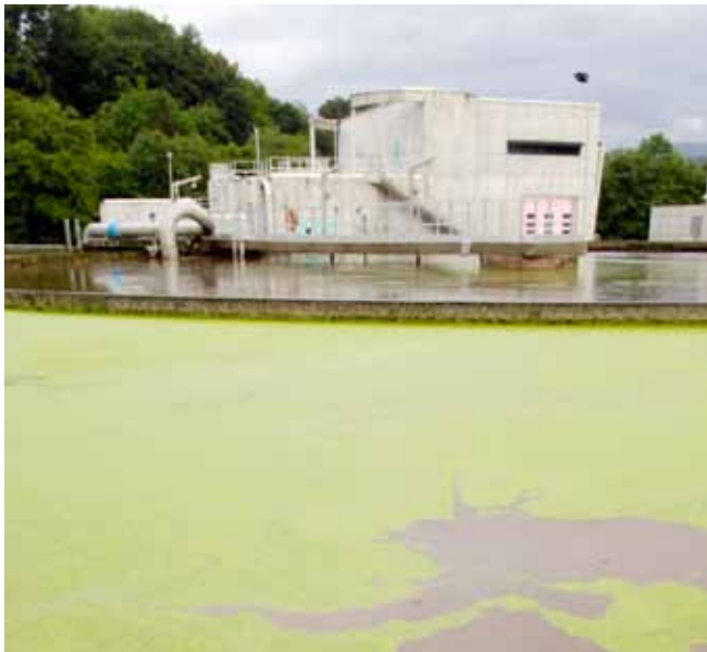
Centre de traitement des déchets
