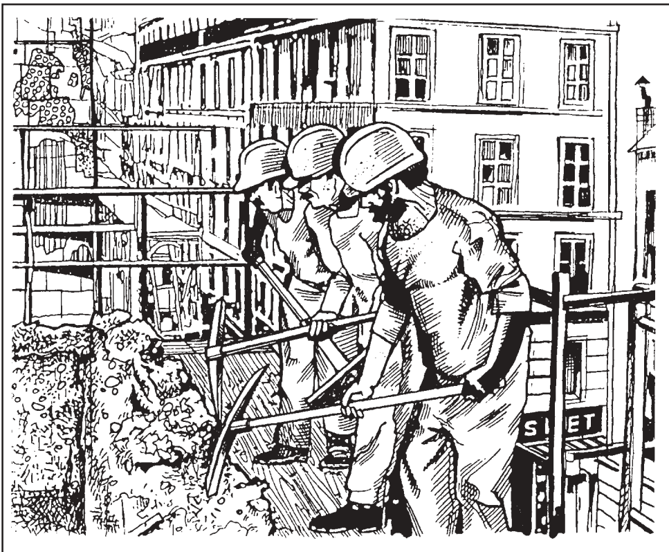
Figura 30. Plataforma de andamio desde la que se puede demoler en condiciones de seguridad.
