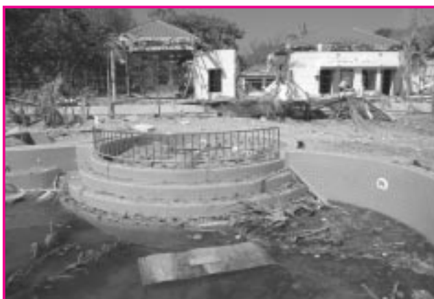
12月26日の津波による被害が最も激しかったタイ沿岸カオラク地区では、ビーチのホテルや商業施設はすべて破壊された。
