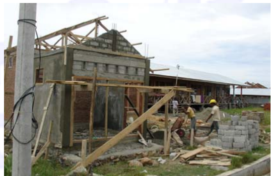
Foto 1: Pembangunan rumah di Meuraxa, Mei 2006
