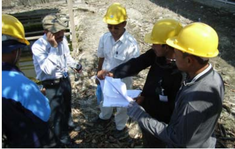
Tim Infrastruktur Padat Karya ILO bersama dengan para kontraktor kecil bersama-sama terlibat dalam pembangunan jalan pedesaan di Banda Aceh.
