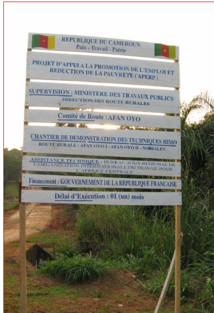
Photo 1 : Plaque d'informations du chantier au PK 00+000
