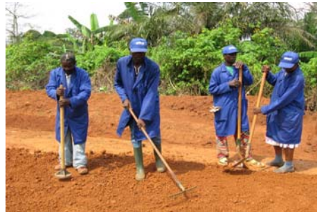
Repandage des matériaux
