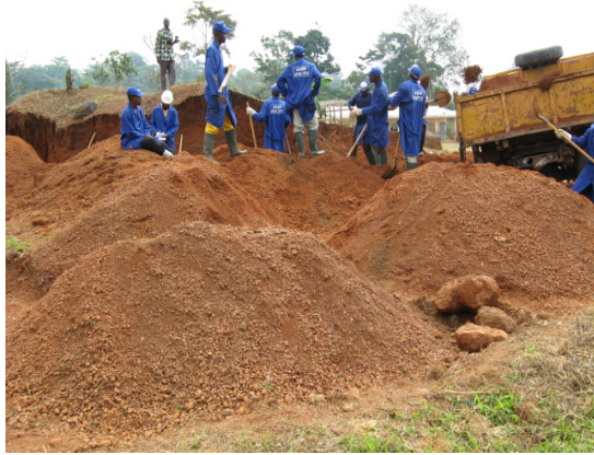
Photo 23 : Travaux de carrière_Chargement de la latérite à la carrière au PK4+00
