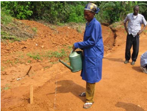
Arrosage de la chaussée
