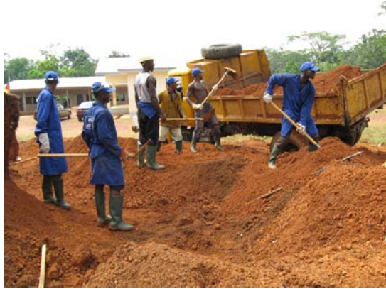
Photo 23 : Travaux de carrière_Chargement de la latérite à la carrière au PK4+00
