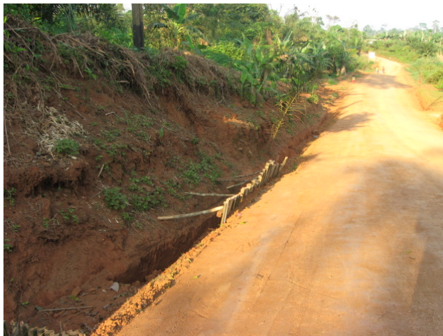
Photo10 : Remblai stabilisé par les contreforts en bambou de chine
