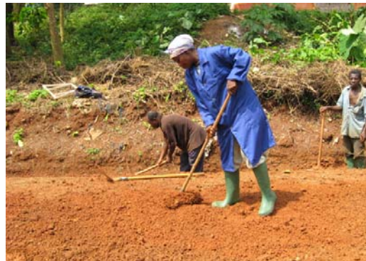
Epandage de la latérite sur la chaussée
