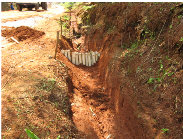
Photo 11 : Fascine n°1 sur le côté droit
