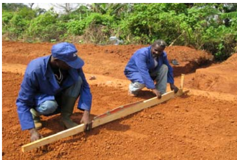
Séance de mise en toit pour avoir une pente de 3%
