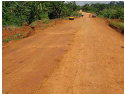
Côté gauche de la chaussée compactée (produit fini)
