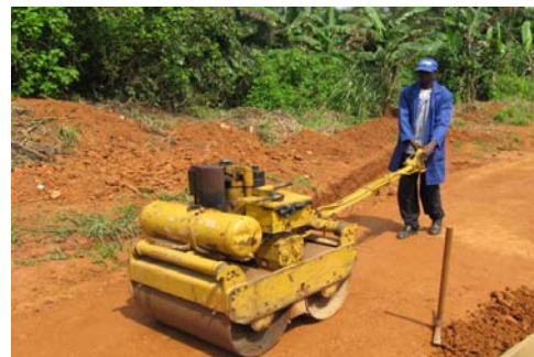
Compactage de la chaussée PK 00+300
