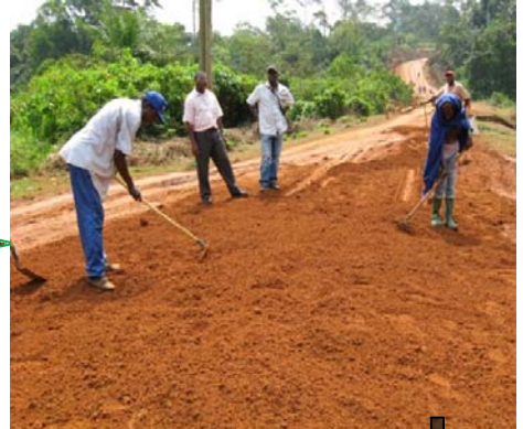
Ouvriers et cadres de formation pendant le chantier (Point critique N° 2)
