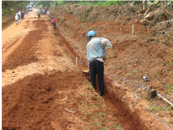
Photo 8 : Création des fossés en sections rectangulaires
