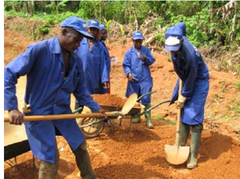
Chargement de la chaussée
